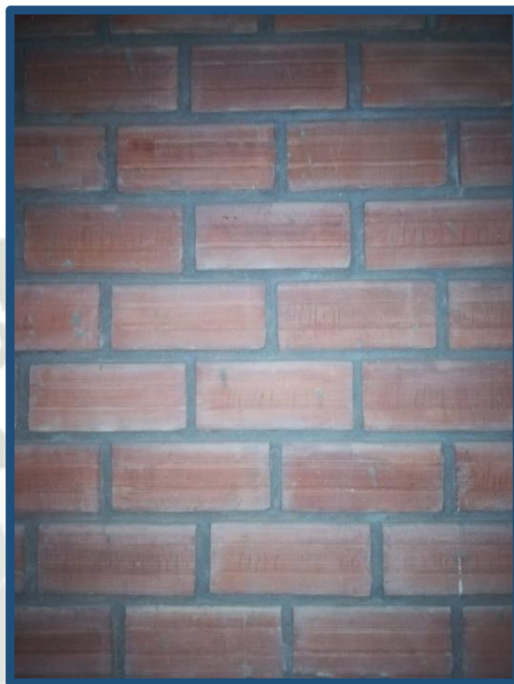
Figura N° 1: Albañilería con junta de 1.5 cm de espesor
