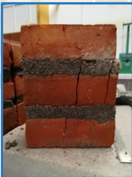
Figura N° 57: Falla por aplastamiento en prisma de unidades artesanales
