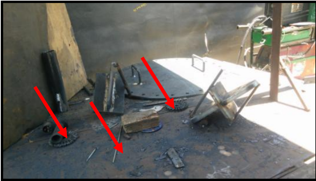
Imagen N° 24. Insumos sobrantes – zona de soldado
