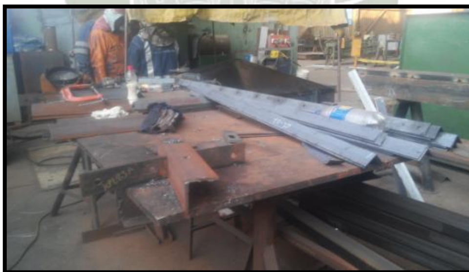
Imagen N° 17. Zona de armado – Almacenaje de piezas habilitadas sobre la mesa de trabajo
