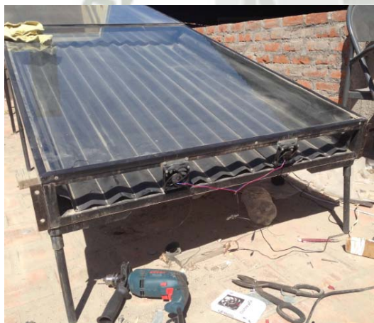
Figura: 2.21 Foto que muestra la chimenea que contiene válvula controlada y ventiladores
