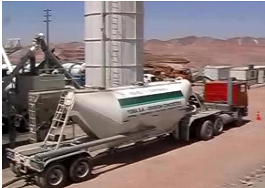
FIGURA 1.8 Equipos de Transporte de Materias primas
