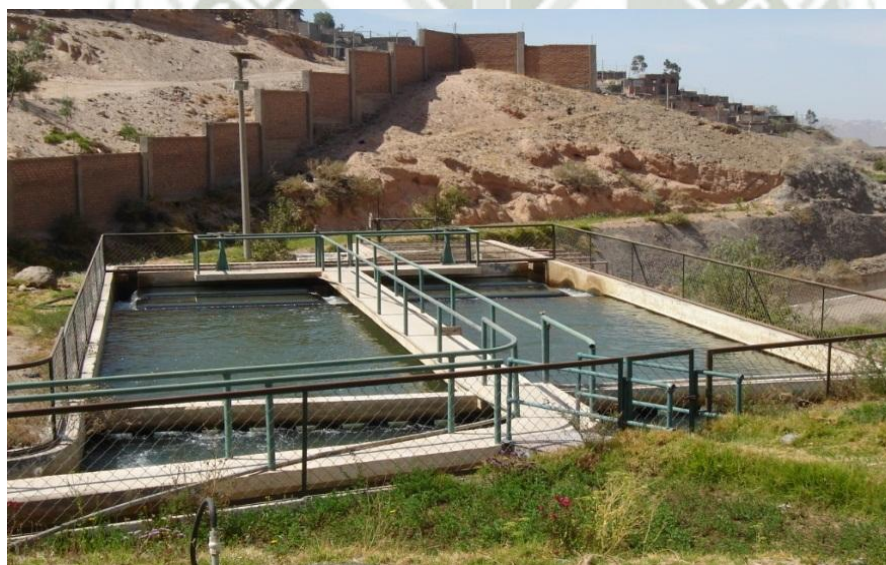
FIGURA N° 4: POZOS DESARENADORES.
