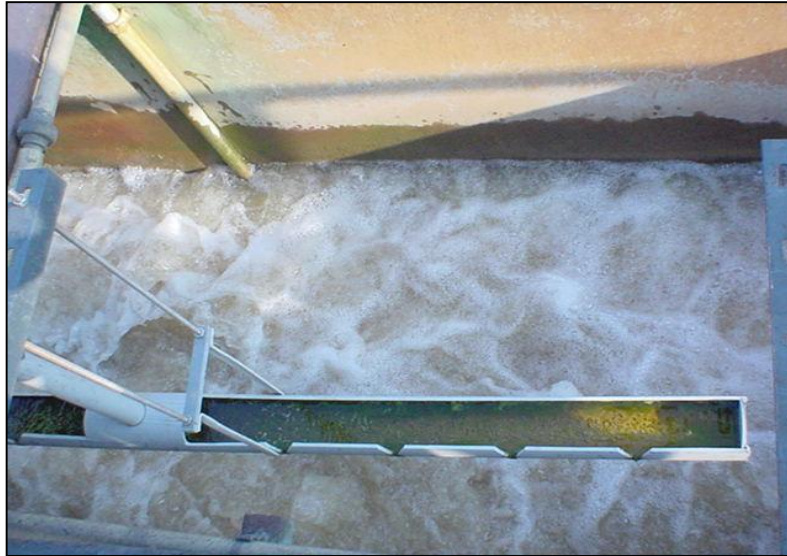
FIGURA N° 5: APLICACIÓN DEL COAGULANTE
