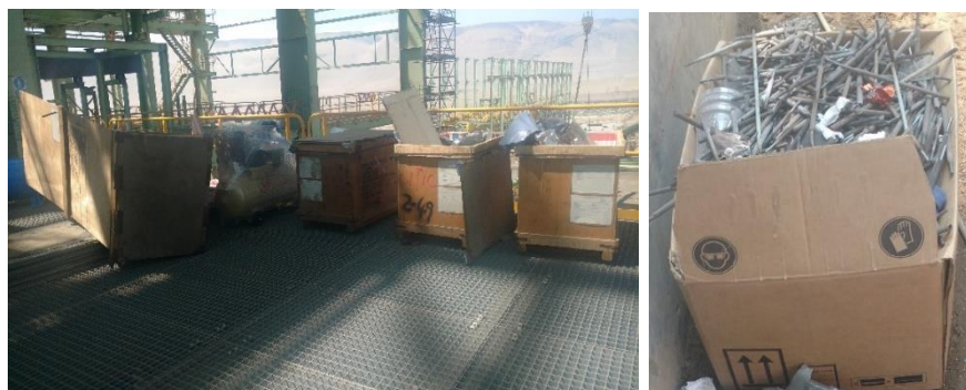
Figura 5: Residuos de madera y residuos peligrosos abandonados en área de Molinos
