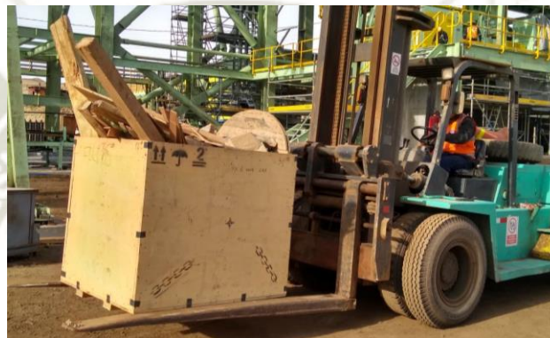
Figura 16: Transporte de Residuos de Madera
