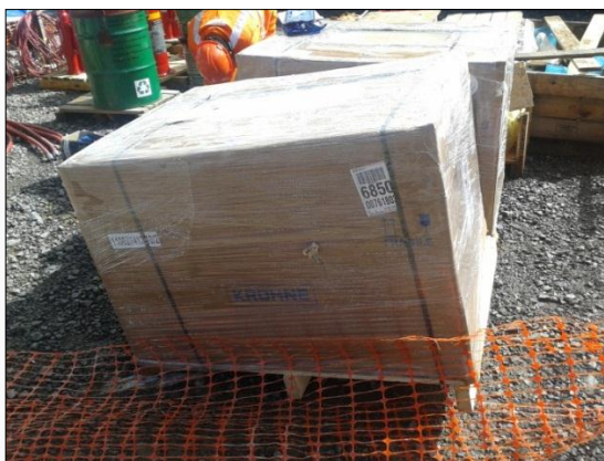
Ilustración 29 - Ejemplo de mala descarga
