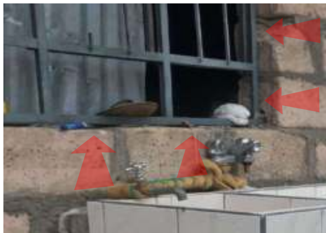
Ilustración 118: Presencia de un elemento con diferente conductividad térmica entre pared y puerta
