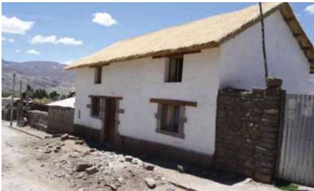
Ilustración 30: Rehabilitación de vivienda Coporaque
