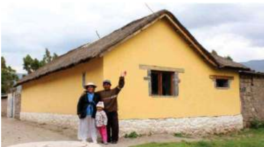
Ilustración 27: Rehabilitación de vivienda en Illupampa. (AECID. 2016)
