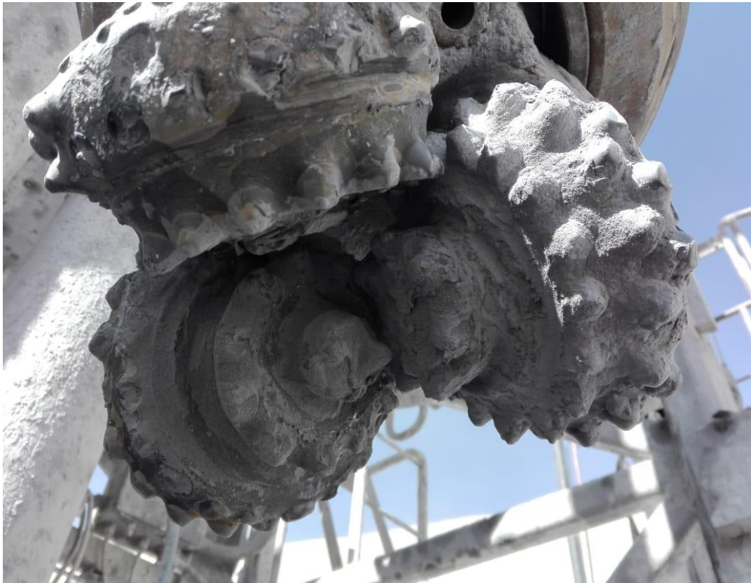
Ilustración 44: Broca Mincon de 11" en plena operación - tajo Toquepala
