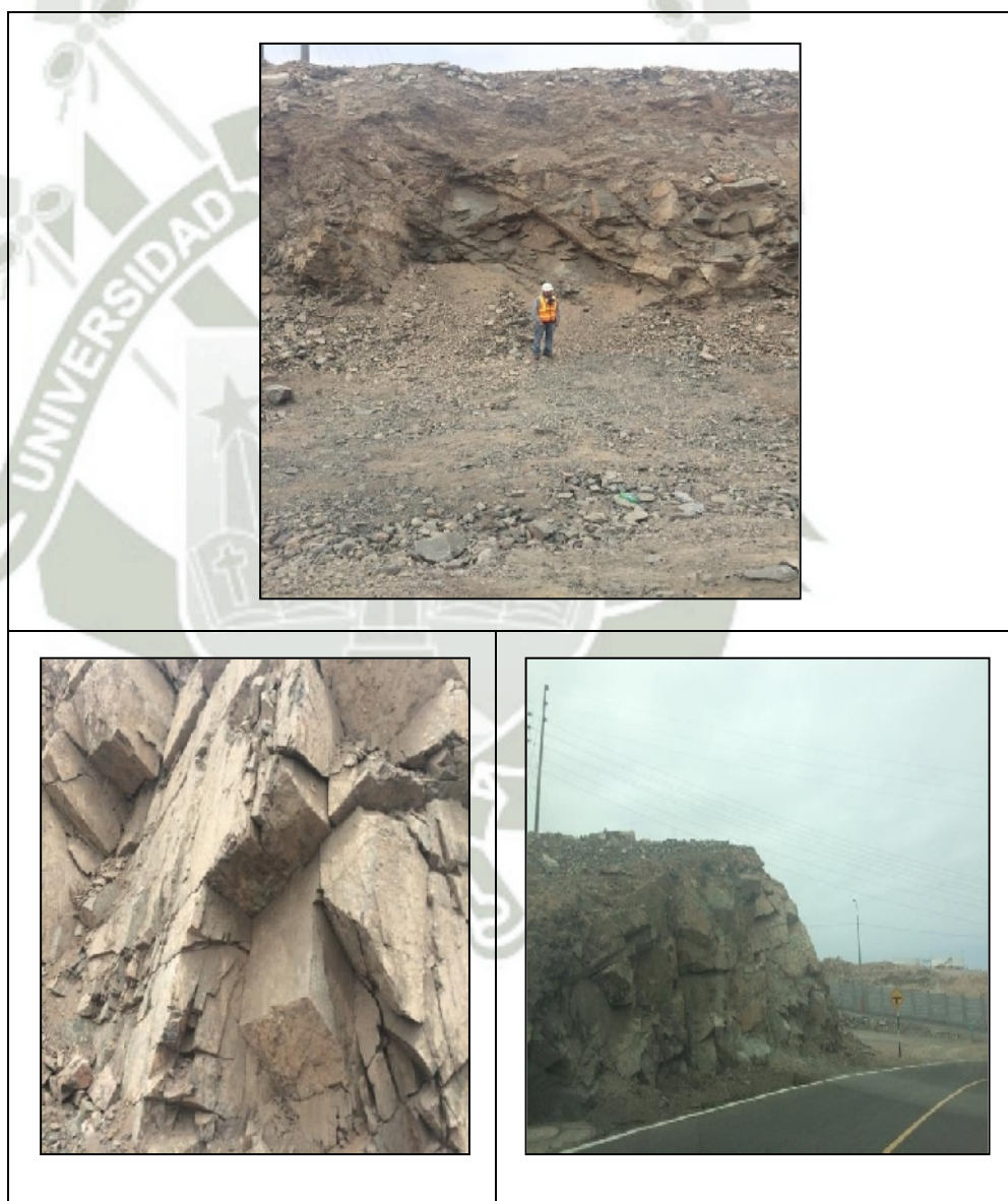
FIGURA N° 3.16. Recorrido en tramo Puramente Roca
