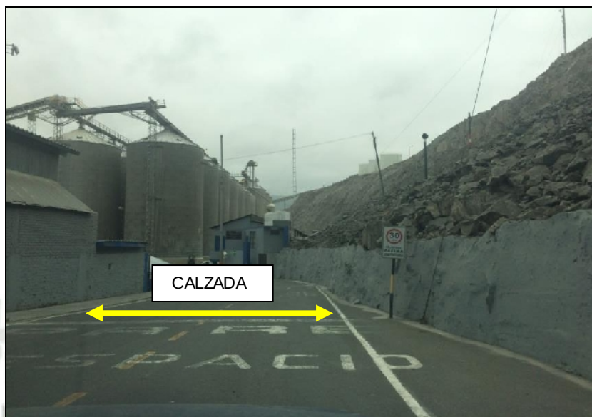
FIGURA N° 3.09. Calzada Típica en el interior del Puerto
