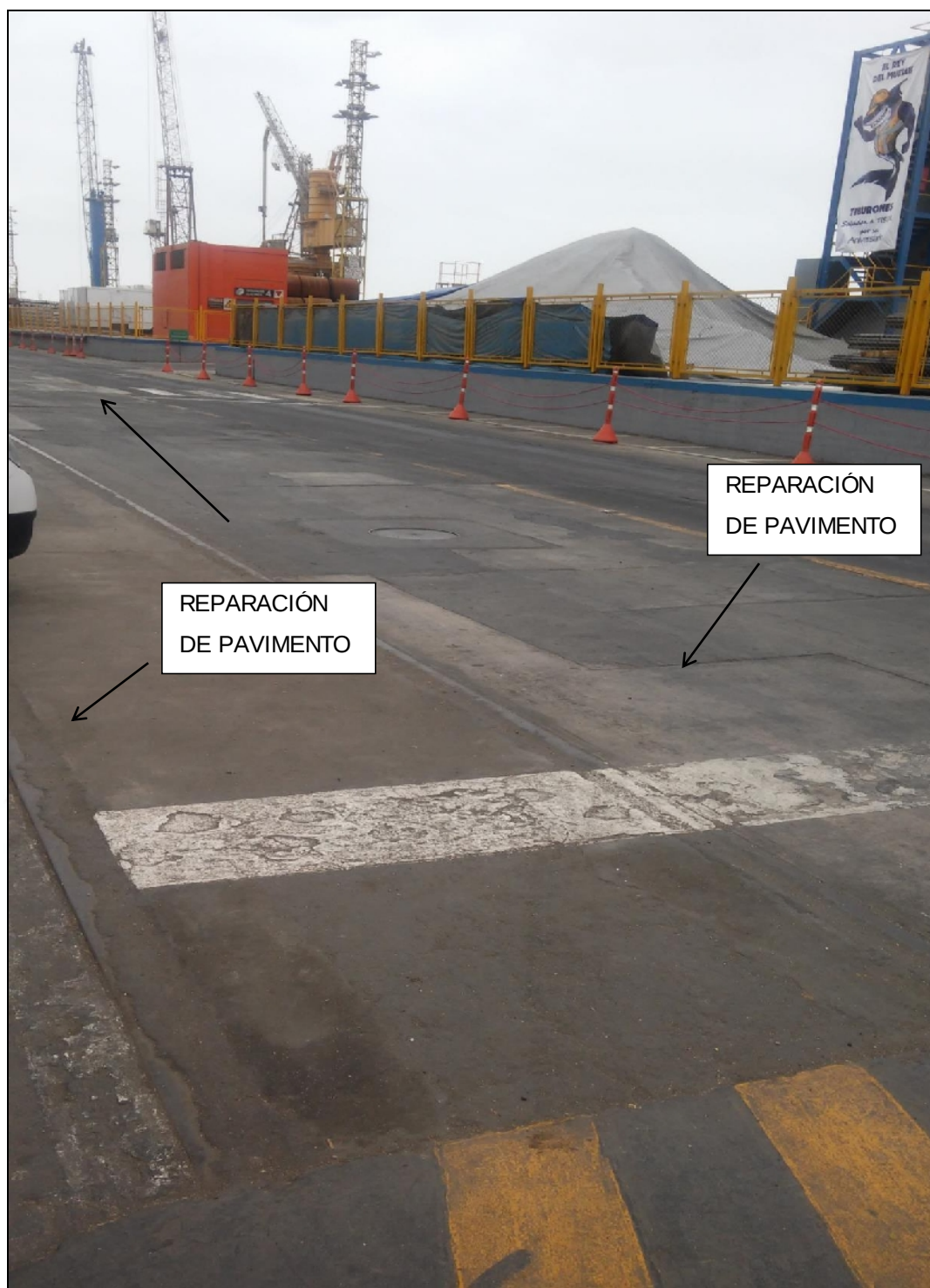
FIGURA N° 2.01. Reparación de pavimentos existentes en el Puerto
