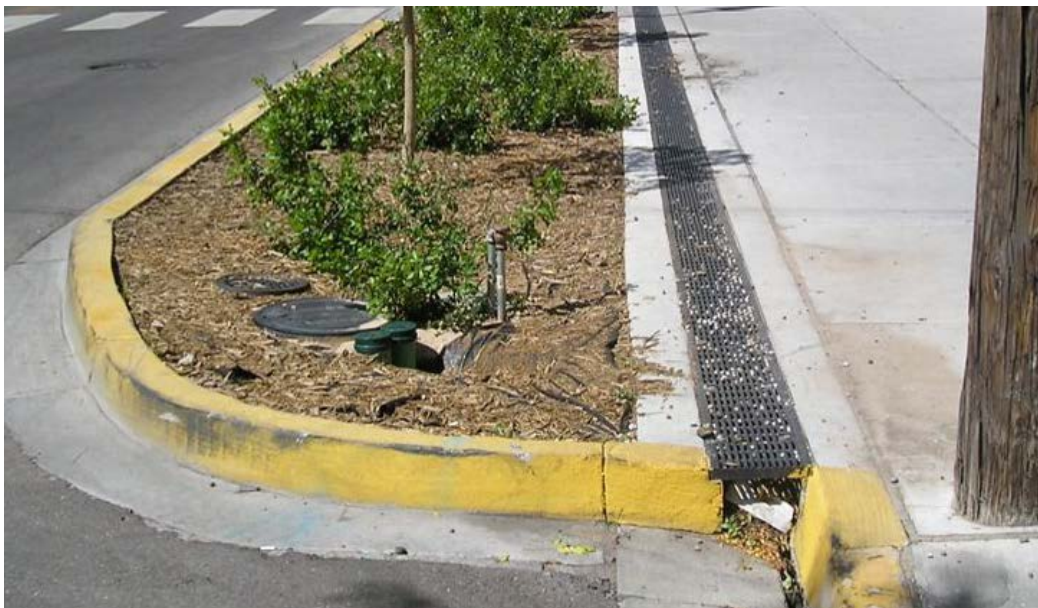
FIGURA 4.9 Ejemplo de aplicación rejilla para tapar drenaje
