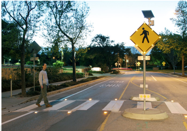
FIGURA 4.10 Ejemplo de ubicación de luces de advertencia “in-roadway warning lights” en un cruce peatonal
