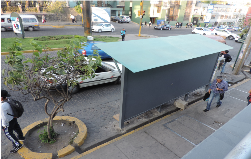
A- Paradero en la intersección ubicado muy cerca de la pista
