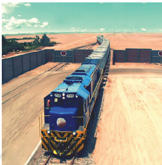
Figura N°24. Tren llevando plataformas hasta instalaciones de Tisur en Matarani
