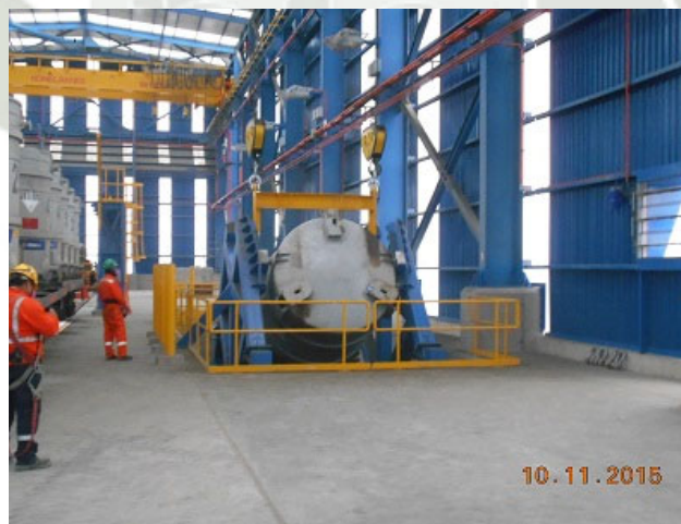
Figura N°29. Volteo de contenedor mediante puente grúa
