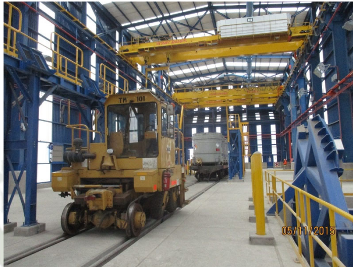
Figura N°26. Ingreso de trackmovil a edificio de recepción férrea
