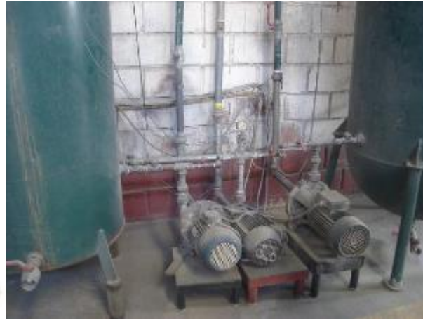
Foto N° 74 Conductores eléctricos Fuente: Elaboración propia
