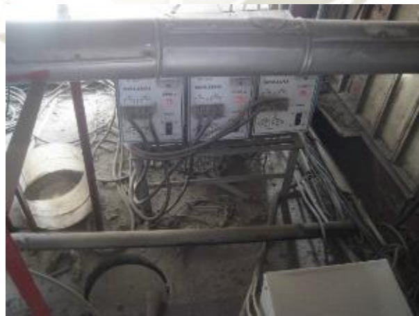
Foto N° 76 Conductores eléctricos Fuente: Elaboración propia
