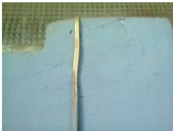
Foto N° 197 (CE4) Conductores eléctricos
