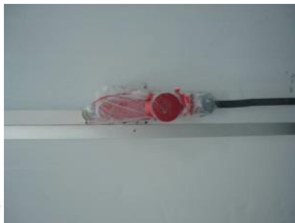
Foto N° 98 Tomacorrientes y enchufes
