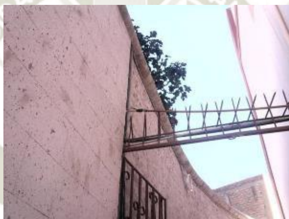
Foto N° 183 (CE4) Conductores eléctricos
