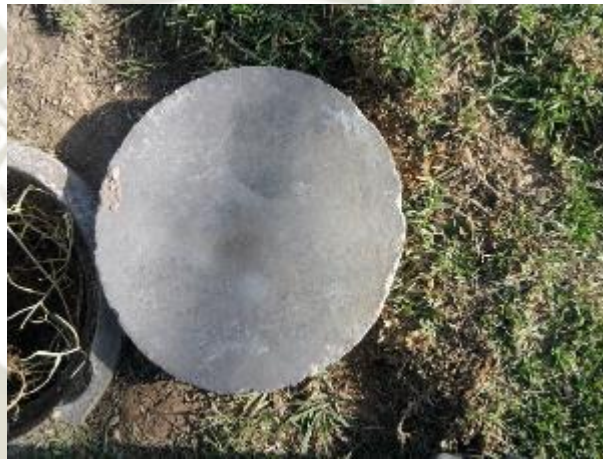
Foto N° 115 Pozos a tierra Fuente: Elaboración propia
