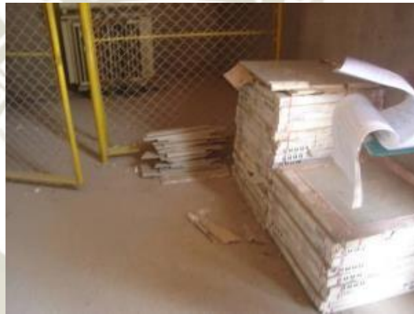
Foto N° 105 Subestación eléctrica Fuente: Elaboración propia Subestación eléctrica
