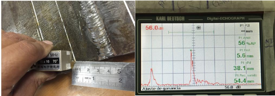
Figura 5-14: Detección de Reflector en unión Soldada
