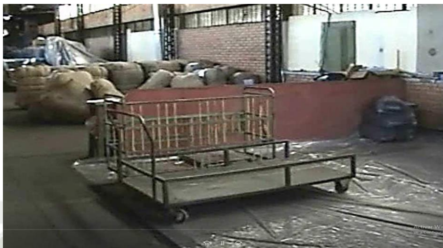
Figura N° 30: Zona de recepción y despacho para limpieza
