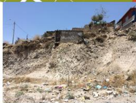
IMG.3: Zonas de peligro a derrumbe. FUENTE: Elaboración Propia
