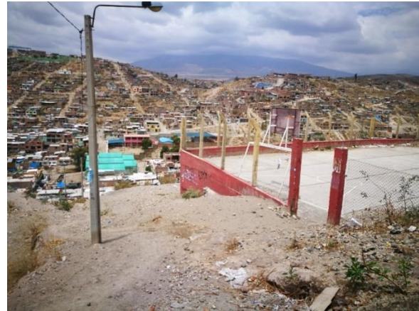
Imagen 9: Área deportiva en el Mirador de Jesús en zona de riesgo y con relleno. Fuente: Propia.
