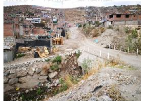
IMG.1: Deficiente tratamiento de borde. FUENTE: Elaboración Propia
