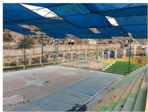
IMG.5: Losa Deportiva Porvenir de Jesús. FUENTE: Elaboración Propia
