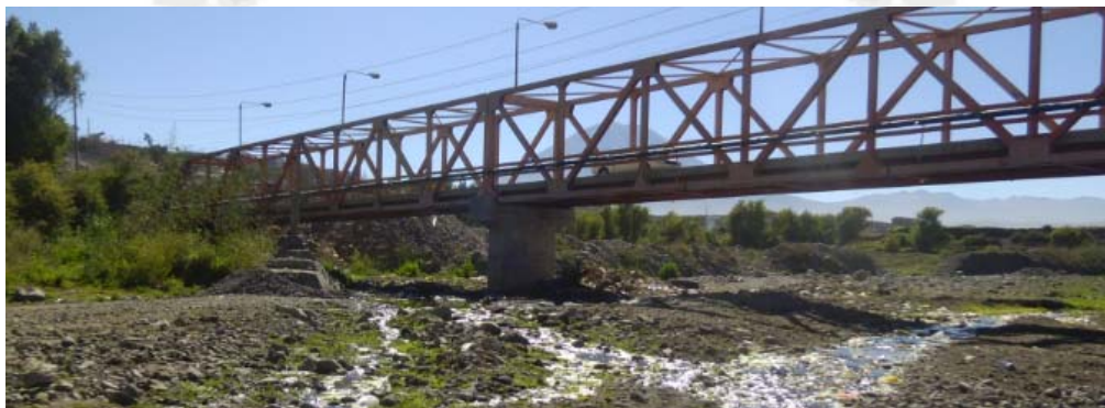
Figura 6. 18, Puente “La mansión del fundador” Ciudad mi trabajo, Socabaya - Arequipa PA
