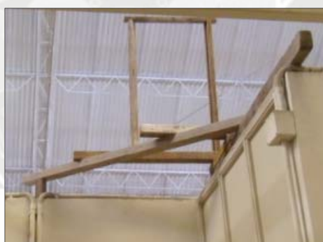
Figura 6. 4, Fijación del soporte de madera para el tanque elevado. PA
