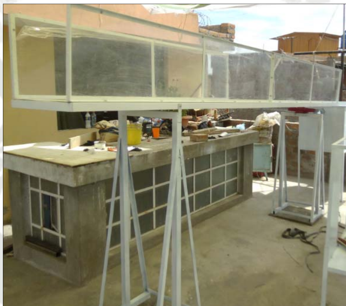
Figura 6. 6, Canal de pendiente variable en el proceso de construcción, antes de prueba de funcionamiento. PA
