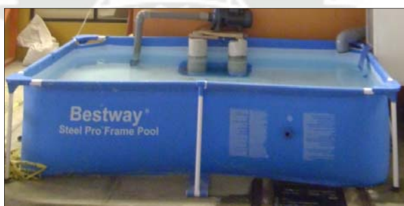
Figura 6. 2, Cisterna del sistema, (Piscina Bestway) PA
