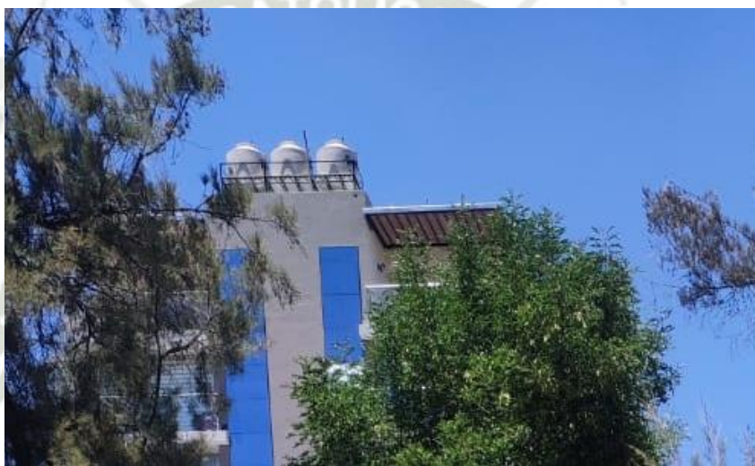
Figura 3.19 Vista de un edificio con tanques elevados
