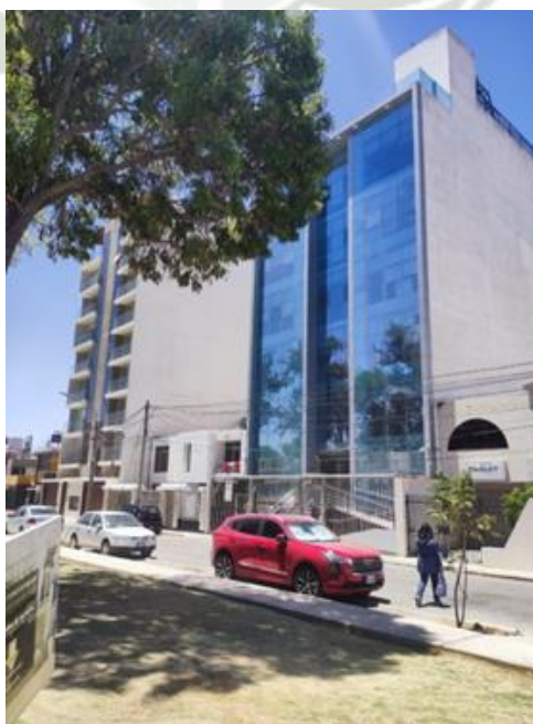
Figura 4 Barrio Magisterial, densificación con demolición previa
