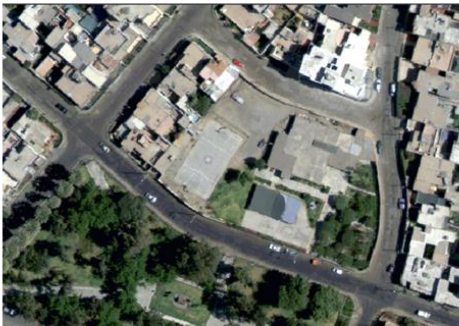
Figura 3.12 Vista de la casa del Maestro
