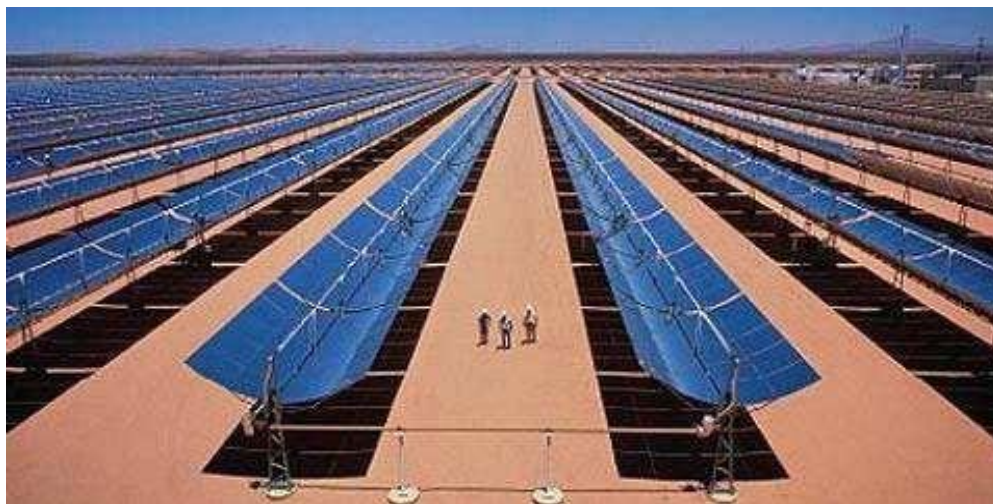
Figura 4. Campo de colectores cilindro parabólicos para planta termosolar de CCP.
