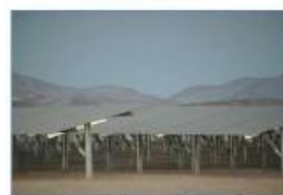
Instalación de Módulos Fotovoltaicos
