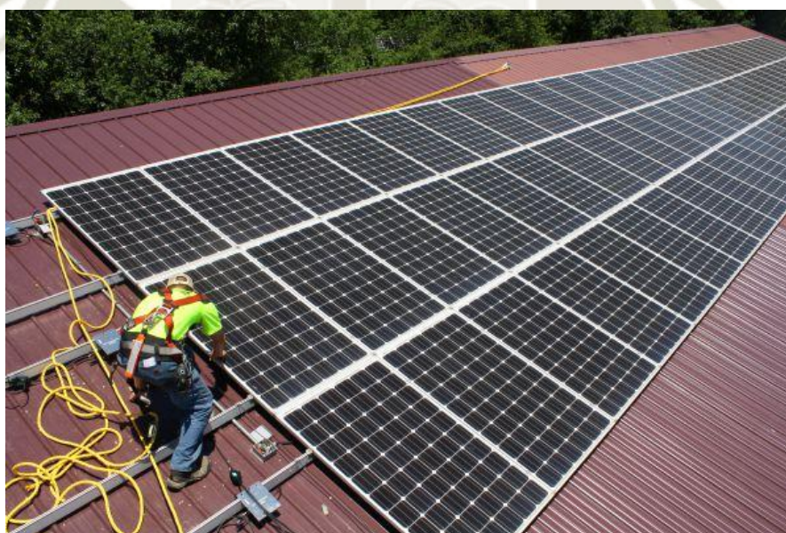
Figura 32. Montaje de paneles solares.
