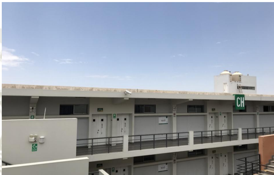
Figura 20. Vista nivel superior pabellón CH.
