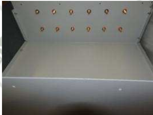
Fig. 40 Instalación de los conectores en el bastidor metálico
