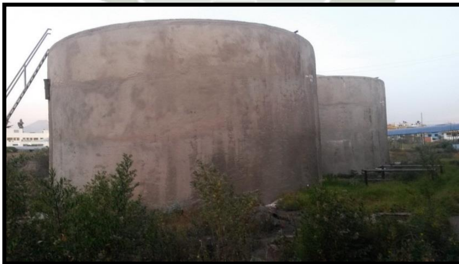
Fotografía 23 Tanques de almacenamiento
