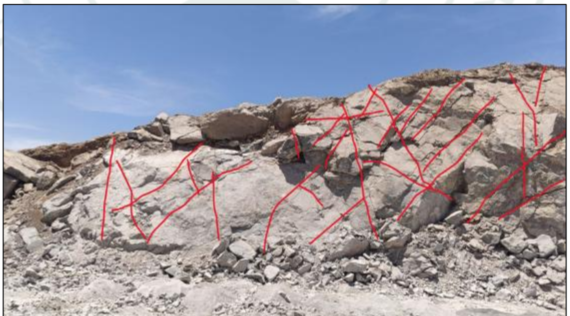
Figura 11. Faja CVC-013, Prog. 0+160 - 0+200 (Alcantarilla 5)
