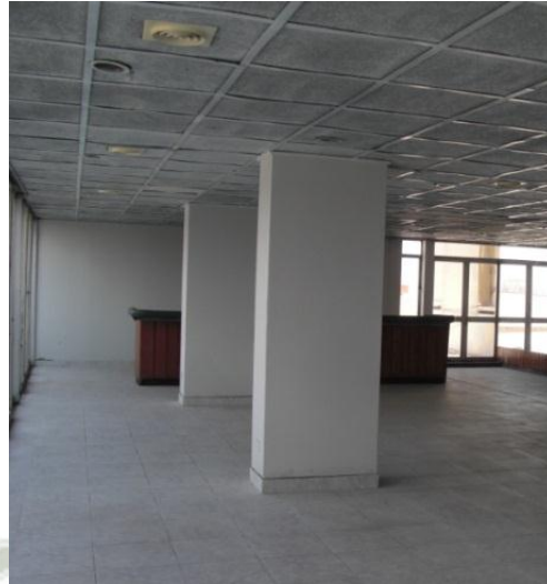
FOTOGRAFÍA 3.15 - COLUMNAS PISO 4 SIN DAÑOS
