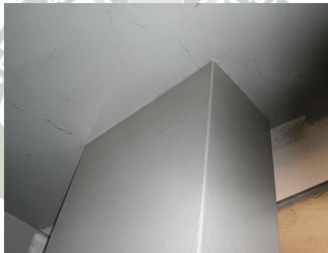
FOTOGRAFÍA 3.7 - COLUMNA "L-6" PISO 12 SIN DAÑOS
