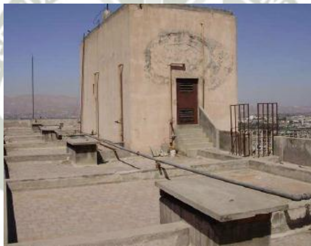
FOTOGRAFÍA 3.2-VISTA AZOTEA Y TANQUE ELEVADO
