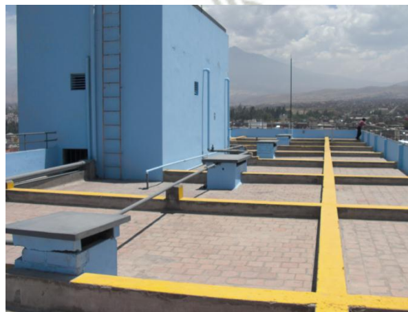
FOTOGRAFÍA 3.3-AZOTEA TANQUE IMPERMEABILIZADO
