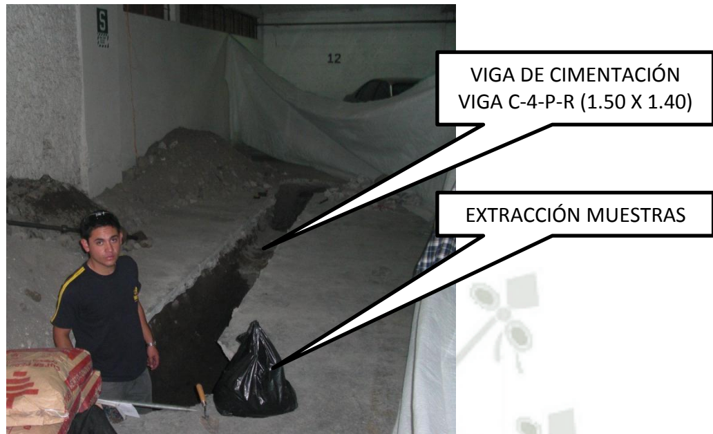
FIGURA 4.85 – EXTRACCIÓN MUESTRAS
