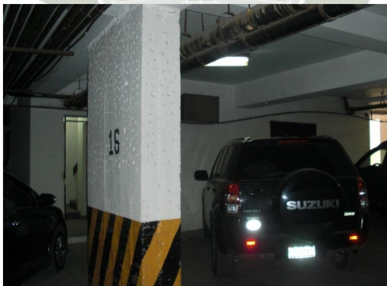
FOTOGRAFÍA 3.18 - SÓTANO SIN DAÑOS
