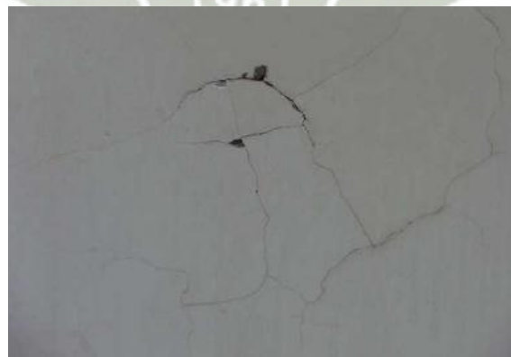
FOTOGRAFÍA 3.5-FISURA TABIQUE COCINA
