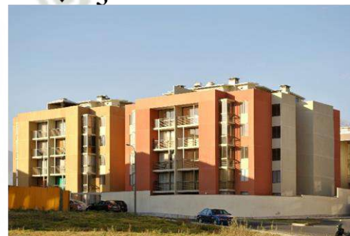
Visual 3: Vista exterior desde espacio público al conjunto habitacional
