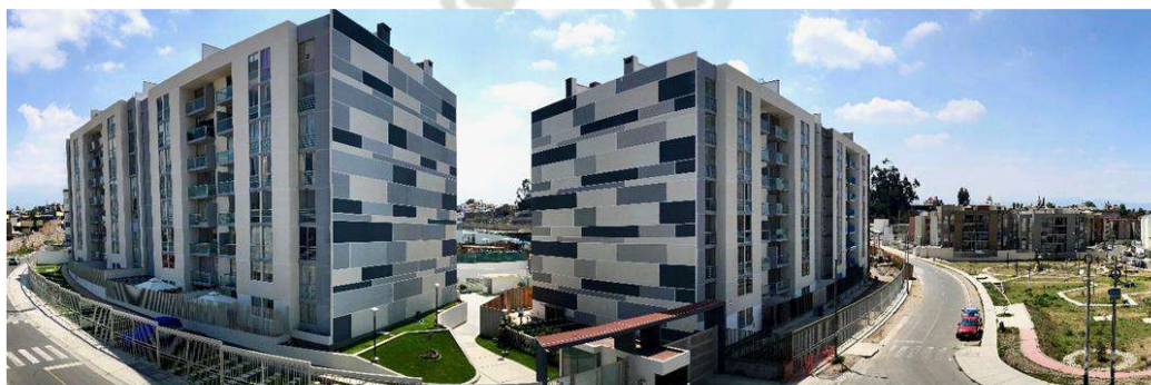
Visual 3: Vista panorámica exterior del conjunto habitacional
