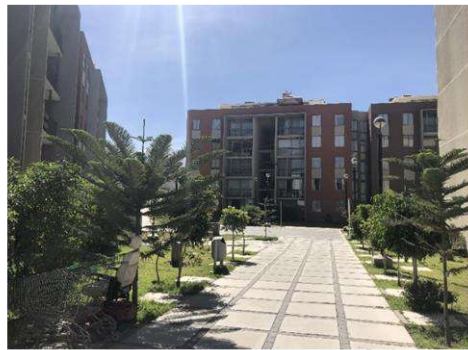
Visual 1: Vista peatonal ingreso a conjunto habitacional
