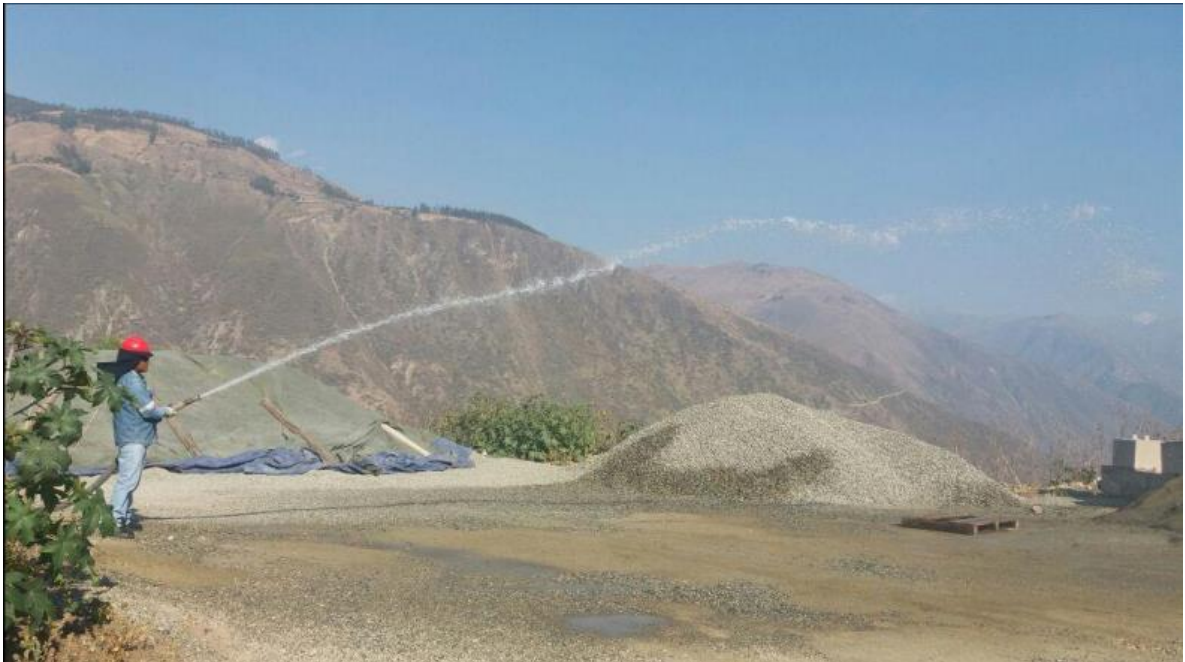
Figura N° 45: Regado de canchas de agregado
