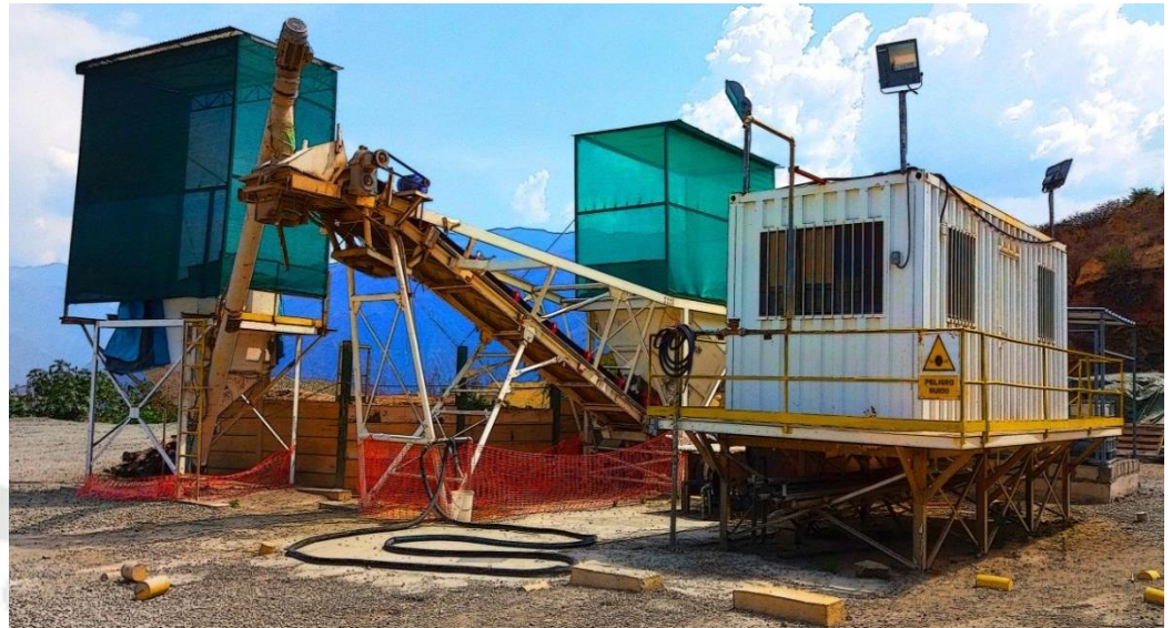
Figura N°12: Planta dosificadora de concreto móvil
