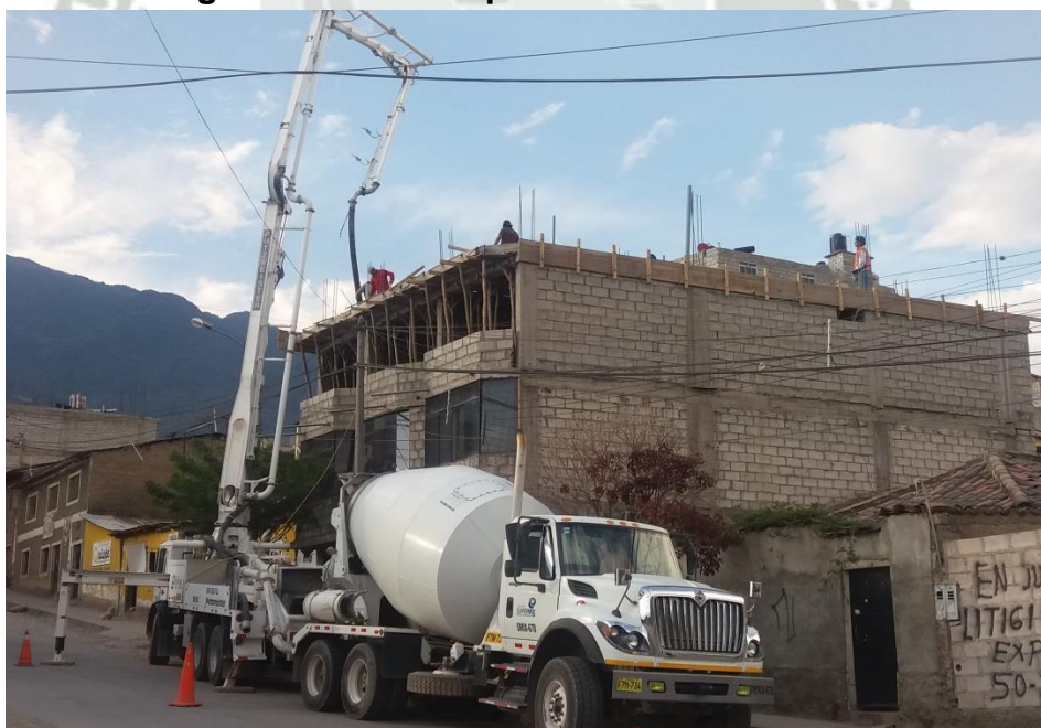
Figura N° 54: Obra particular - Concretecho
