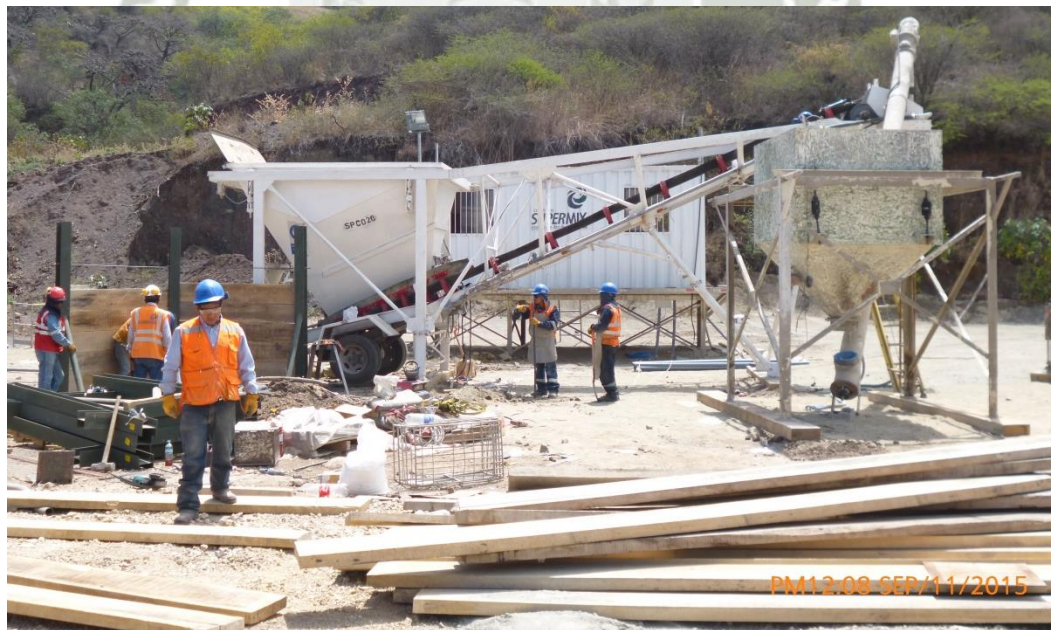
Figura N° 39: Instalación de planta
