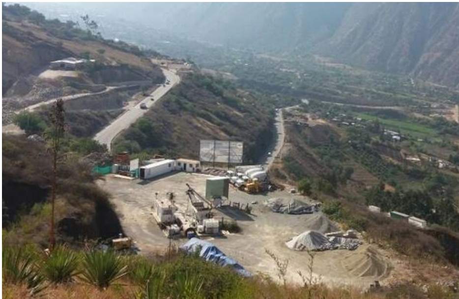
Figura N°3 – Planta de Concreto Premezclado - Abancay
