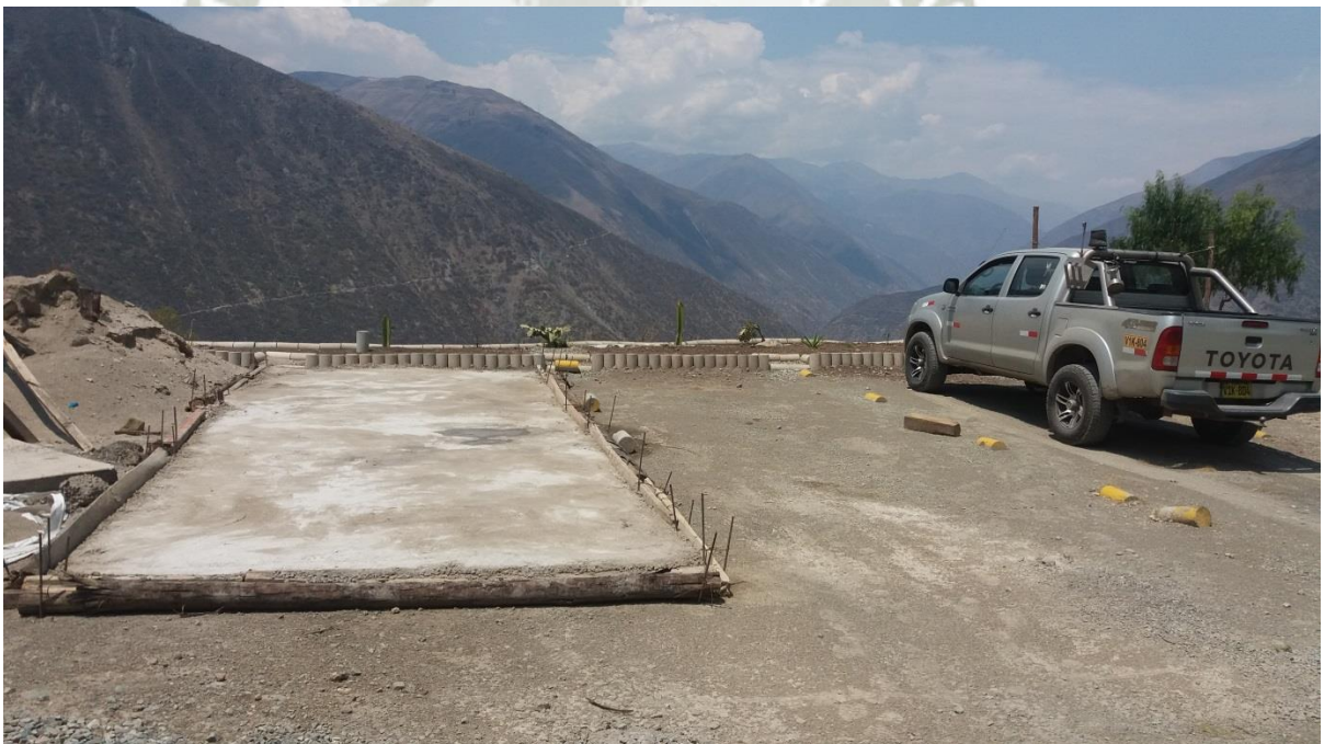
Figura N° 44: Implementación de loza de mantenimiento
