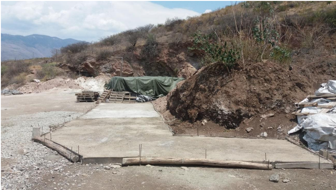
Figura N° 43: Implementación de loza de almacén cements
