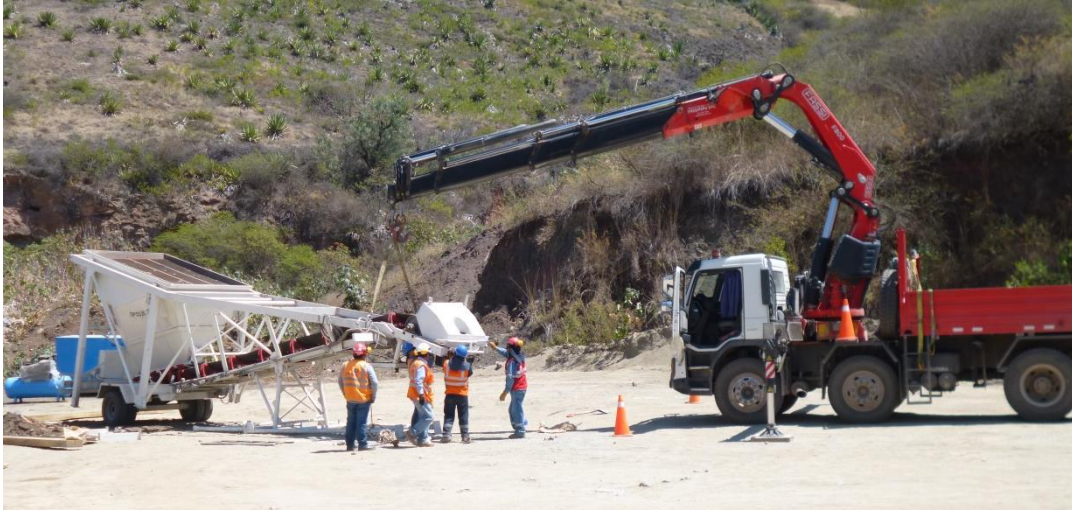
Figura N° 38: Montaje de planta
