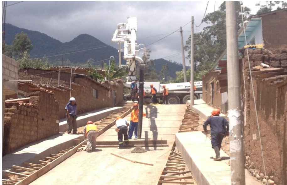
Figura N° 53: Obra pistas y veredas
