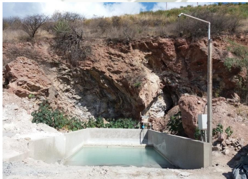
Figura N°9: Poza de lavado de camiones
