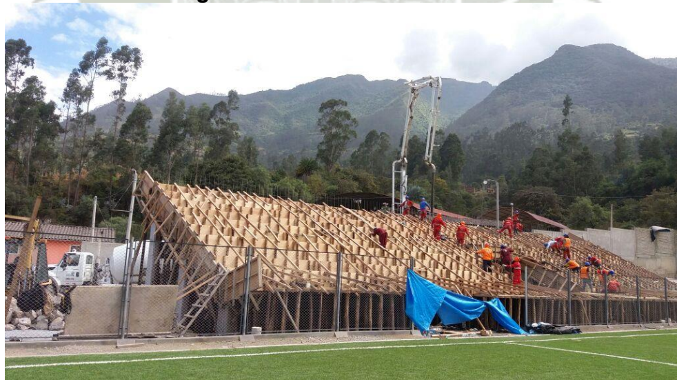
Figura N° 56: vaciado de tribuna
