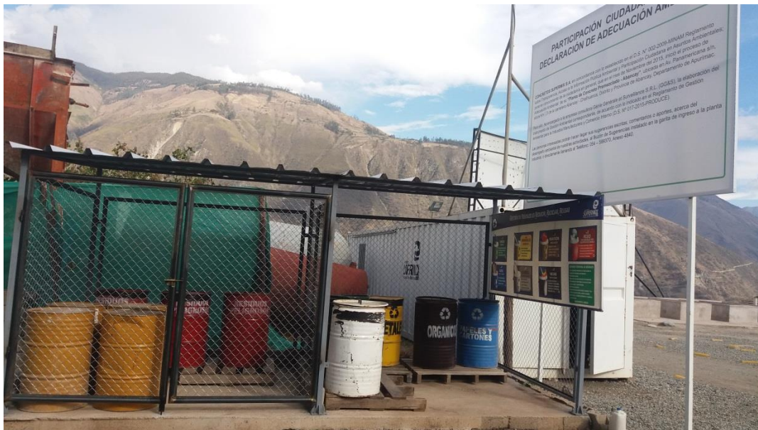
Figura N° 41: Implementación de almacenes de residuos peligrosos y no peligrosos
