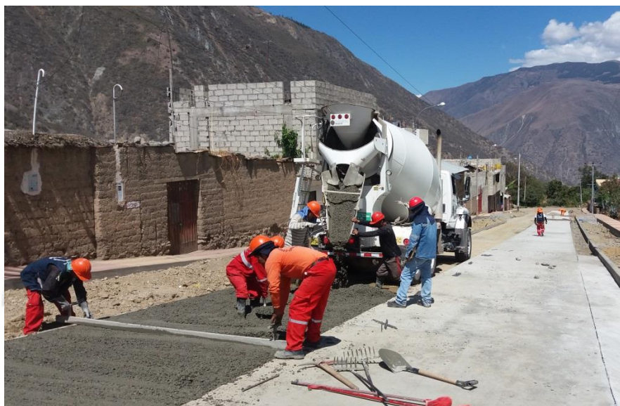
Figura N° 55: Obra pistas y veredas 2
