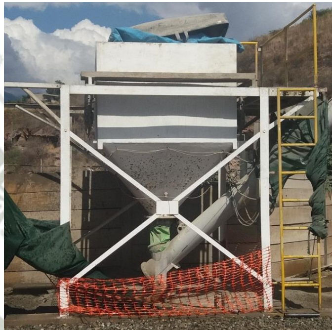
Figura N°14: Tolva de cemento
