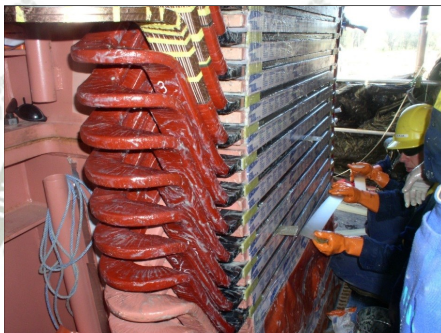
Figura 3.1. Instalación estator del molino SAG.
