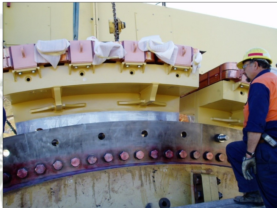
Figura 3.2 Montaje en campo de uno de los polos del rotor. Fuente: Siemens
