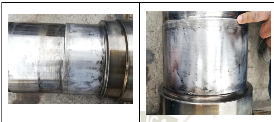
Figura 4.2: Estado inicial de las zonas afectadas. - Elaboración propia
