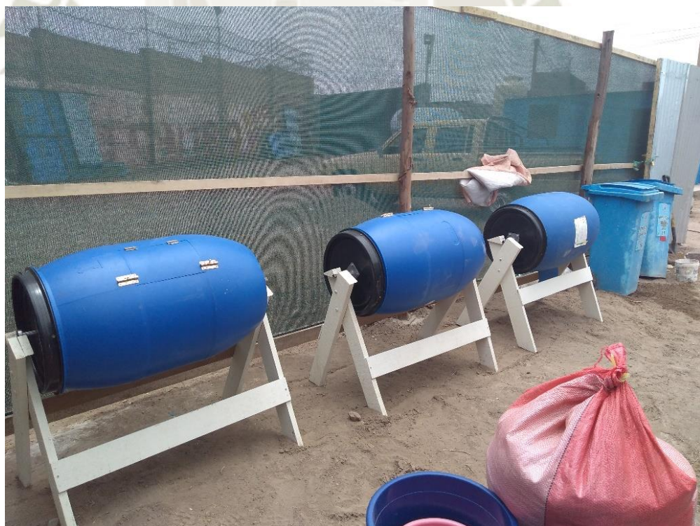
Fotografía N°3: Instalación de compostadores
