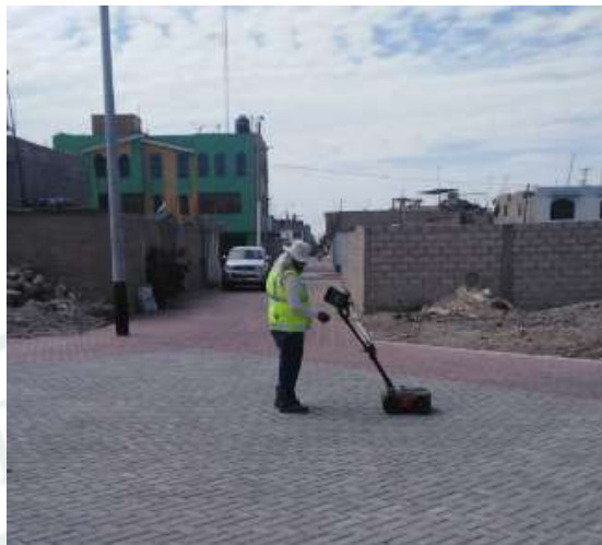
Figura 5: Escaneo de redes con el georadar de marca GSSI
