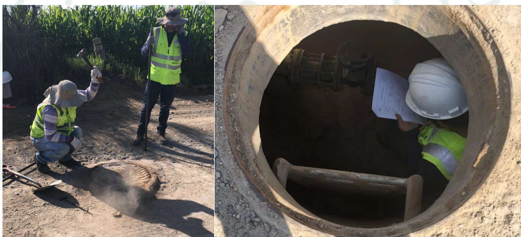
Figura 10: Apertura y levantamiento catastral de una cámara
