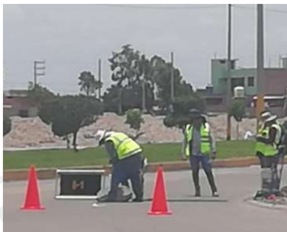
Figura 11: Levantamiento de buzones de inspección de alcantarillado
