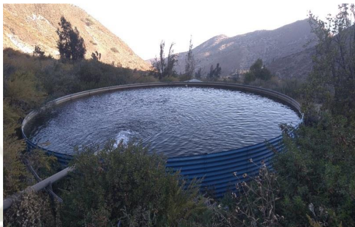
Figura 1: Reservorio metálico de 400m 3 (Sector Cohacho)
