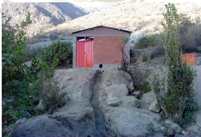
Figura 2: Caseta de los Filtros.
