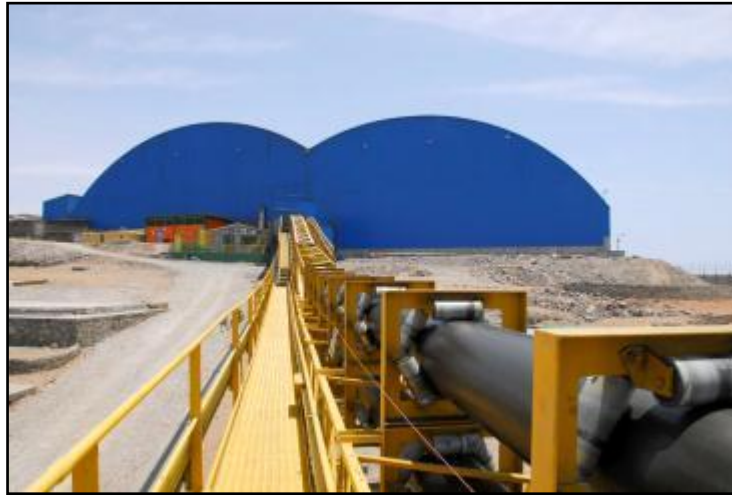
Imagen N° 1: Almacenes coberturados (120,000 TM capacidad)
