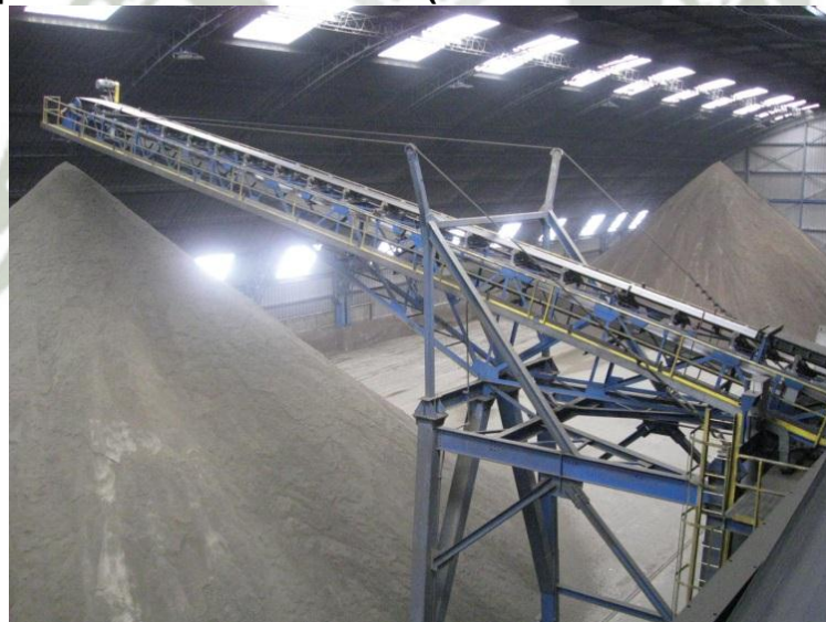
Imagen N° 2: Apilador Móvil / Padloader (Altura de ruma 16 metros)
