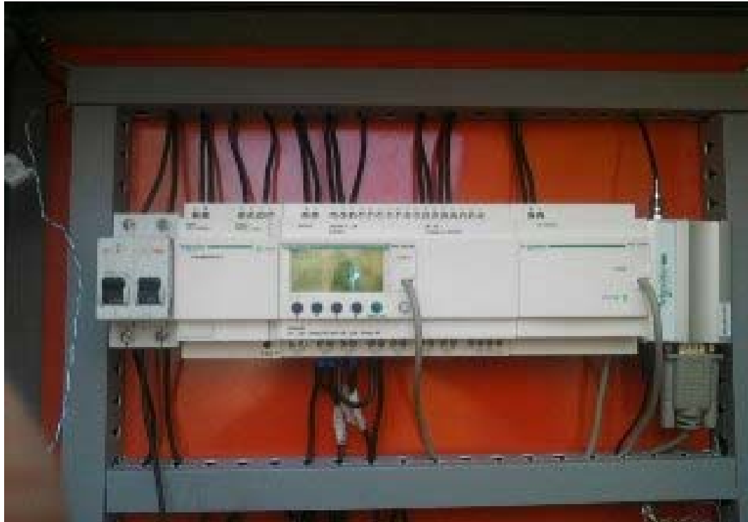
Figura 104 Instalación De Hardware
