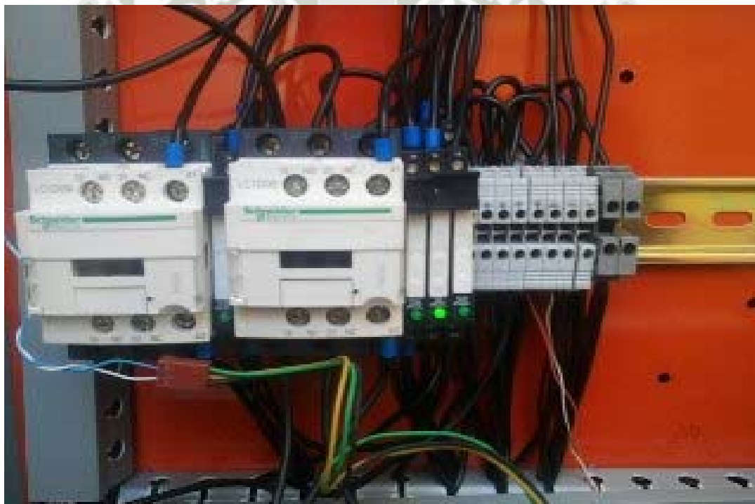
Figura 103 Instalación De Hardware
