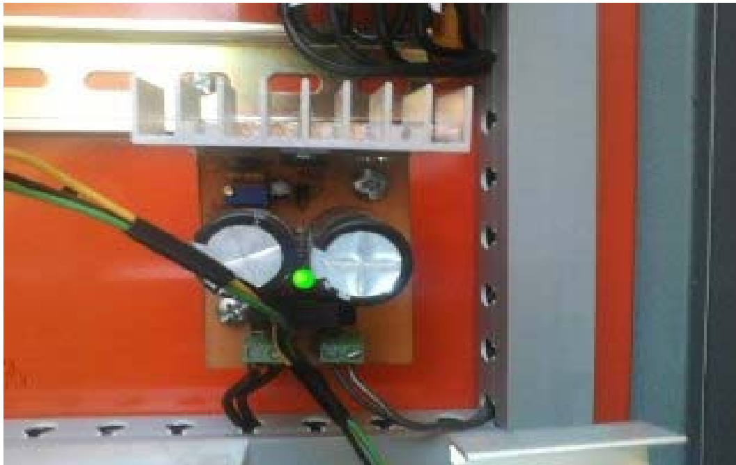
Figura 101 Instalación De Hardware
