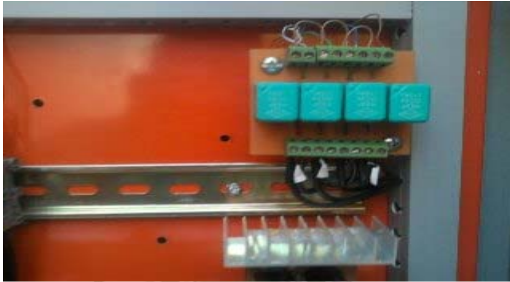
Figura 102 Instalación De Hardware
