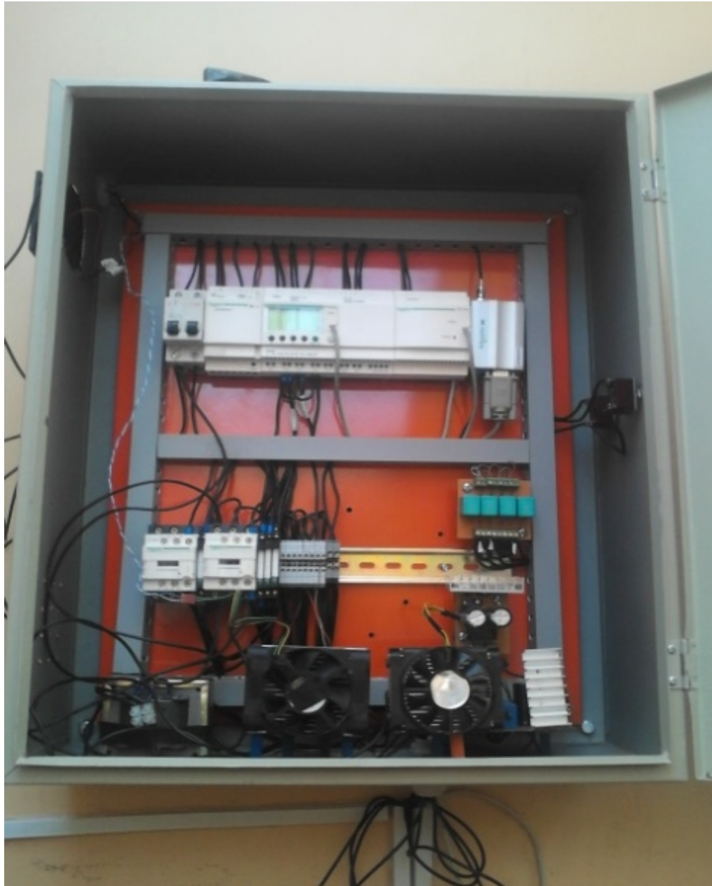
Figura 107 Instalación De Hardware
