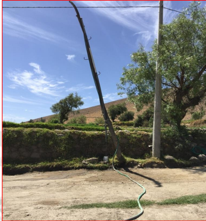
Figura N° 50: Tubería de descarga Fuente: Propia
