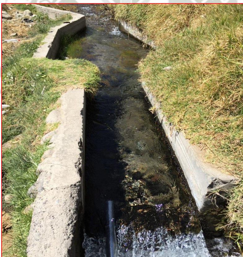
Figura N° 47: Toma de tubería de impulsión
