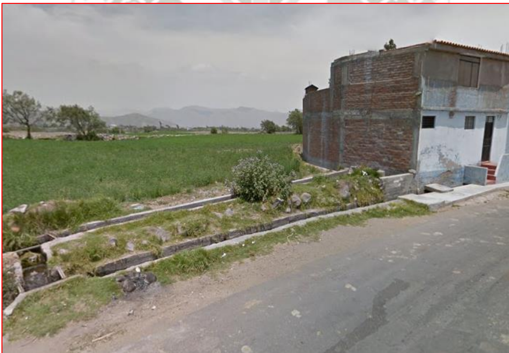
Figura N° 35: Canal de agua Fuente: Propia
