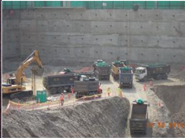
Etapa de Estabilización con Muros Pantalla
