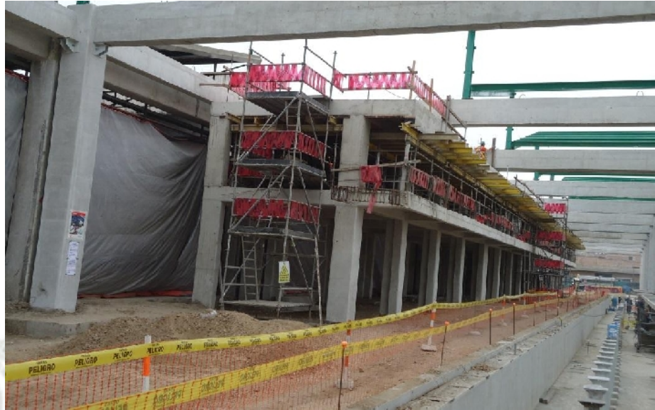
Construcción de Oficinas
