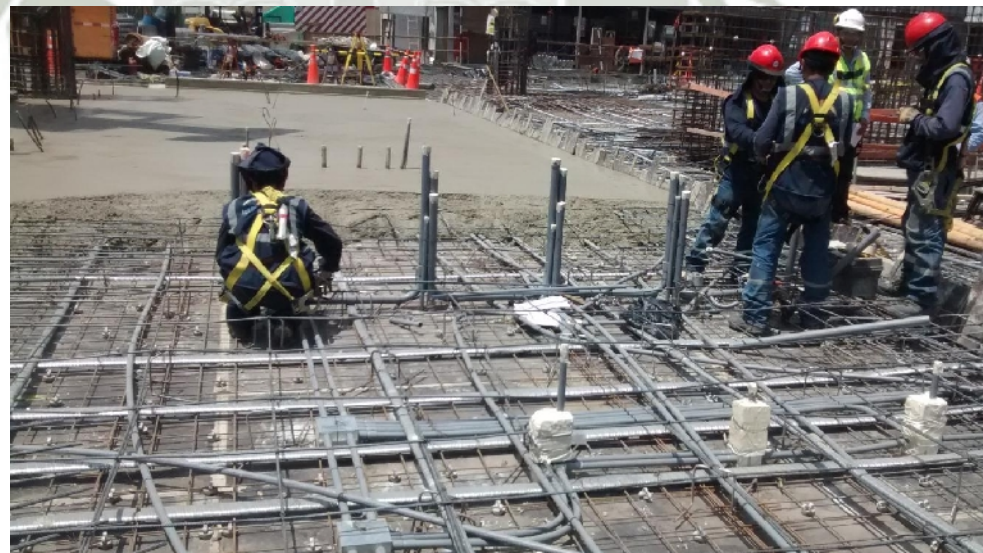
Preparación de Losa Postensada en Sótanos
