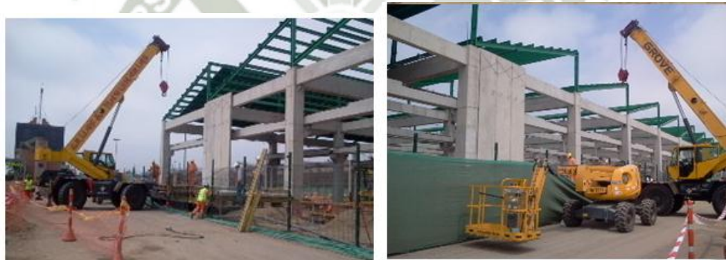
Izaje de Estructura Metálica para Techo
