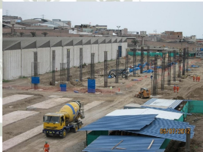
Prearmado de Columnas
