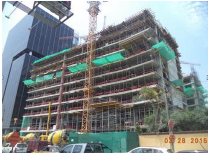
Vista de Ejecución de Obra Torre A-Piso 9
