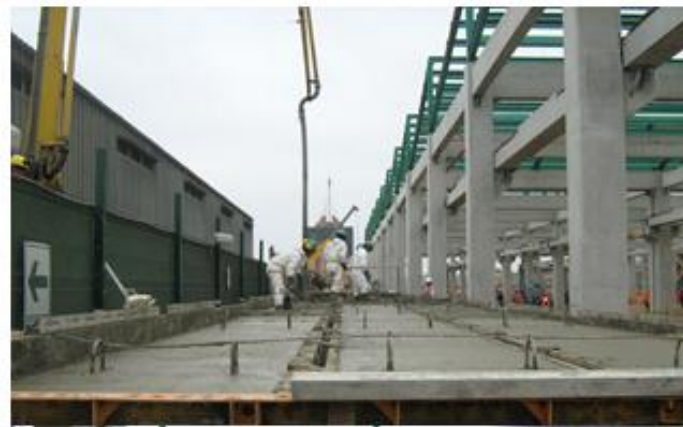
Vaciado de Paneles Prefabricados
