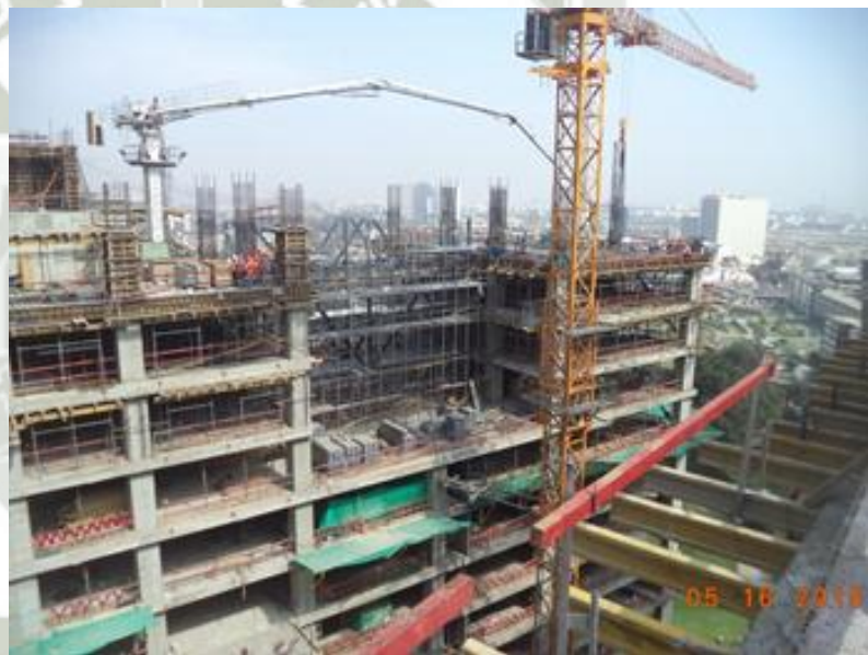
Vista de Construcción de Torre B con vista al Golf
