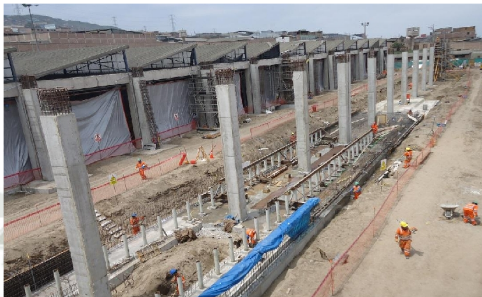
Construcción de Fosa de Inspección
