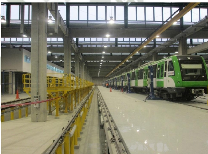
Fosa de Inspección-Entrega de Obra
