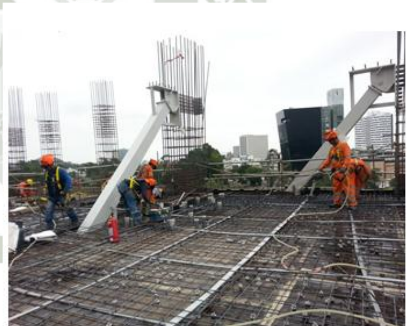
Colocación de Disipadores Sísmicos en Torre
