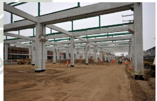
Construcción de Patio de Mantenimiento Mayor
