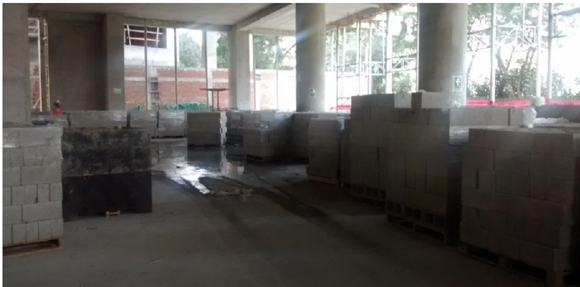
Almacenamiento de Bloquetas de Concreto para Albañilería
