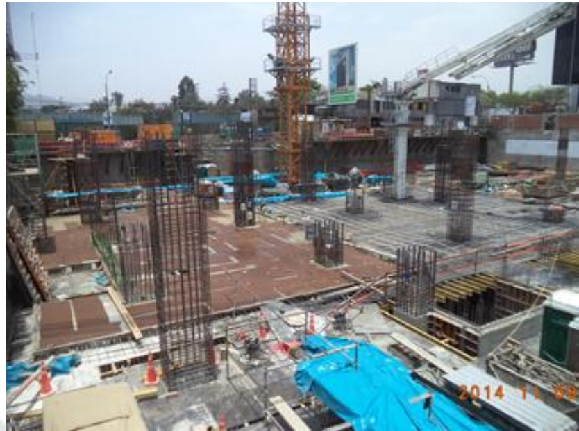
Curado de Losas Primer Sótano 1- Grúas Torre-Placing Boom
