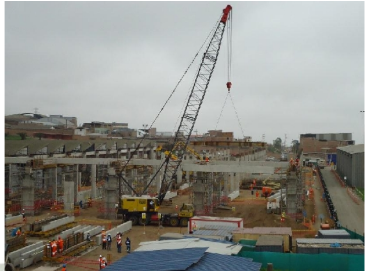
Montaje de Vigas Prefabricadas
