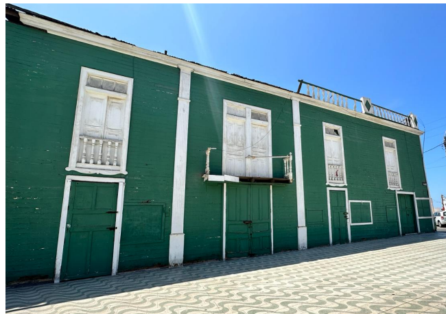
Imagen 63: Vista diagonal de la fachada Plaza Grau
