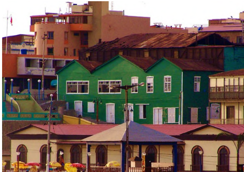
Imagen 86: Vista de las cubiertas secundarias
