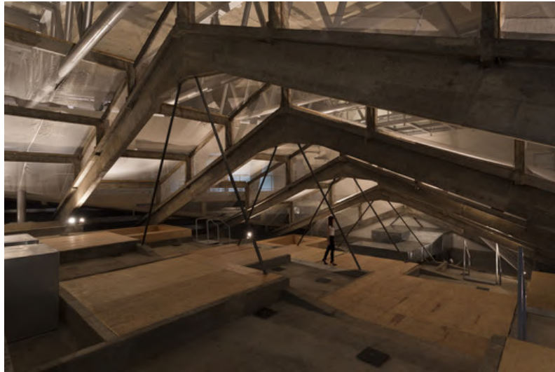
Imagen 25: Estructura interior del techo escalonado
