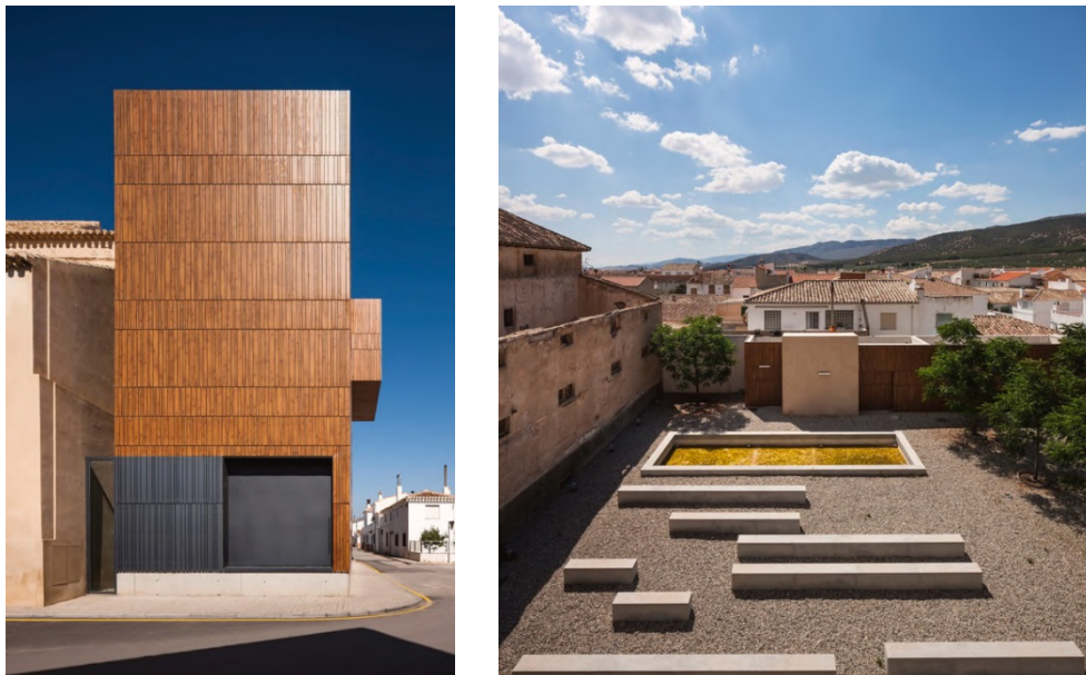
Imagen 14: Vista exterior de la fachada sur
