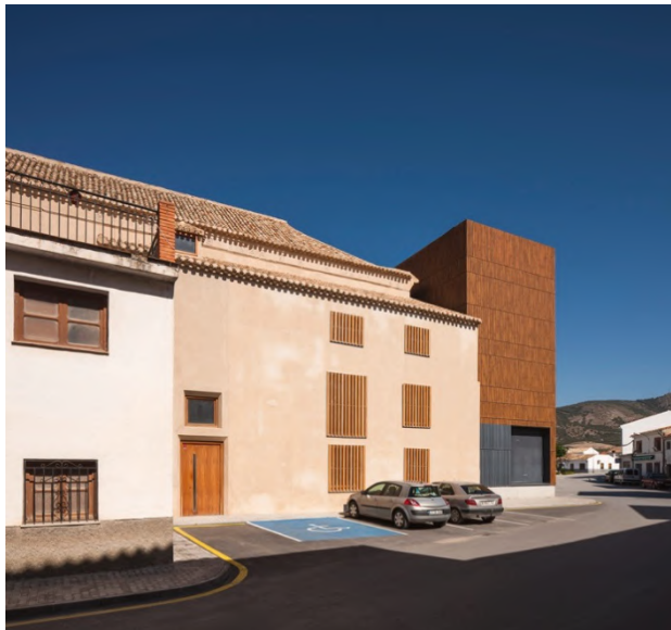
Imagen 13: Vista exterior de la fachada sur
