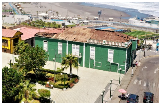
Imagen 85: Estado actual de la cubierta principal
