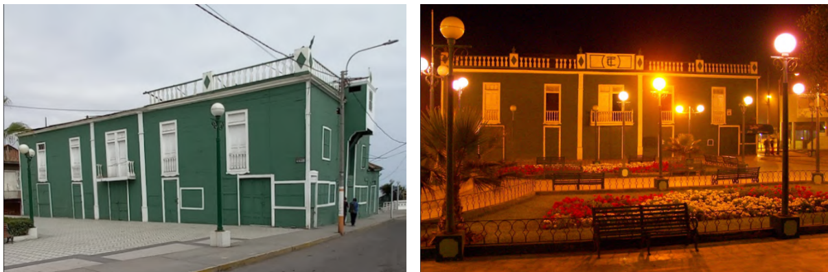
Imagen 88: Fachada principal actual y ornamentación original.
