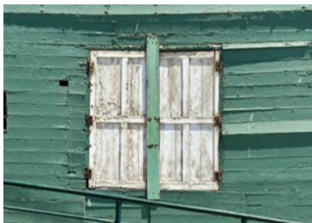
Imagen 73: Meteorización en carpintería
