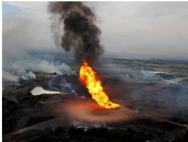
Foto 4: Escape de Gas en gaseoducto
