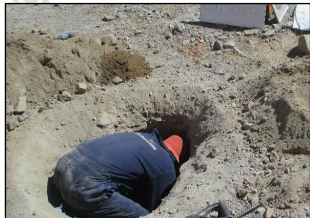
FOTOGRAFIA AII.12 EXCAVACIÓN DE CALICATA
