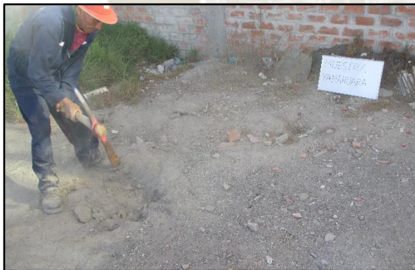
FOTOGRAFIA AII.7 EXCAVACIÓN DE CALICATA
