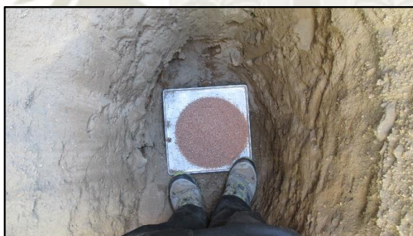
FOTOGRAFIA AVI.8 ENSAYO DE DENSIDAD EN CAMPO
