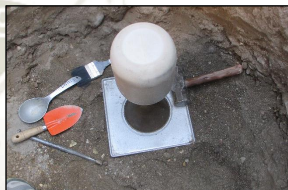
FOTOGRAFIA AVI.8 ENSAYO DE DENSIDAD EN CAMPO
