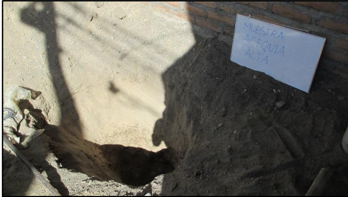
FOTOGRAFIA AII.1 EXCAVACIÓN DE CALICATA
