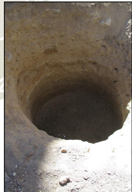
FOTOGRAFIA AII.8 CALICATA
