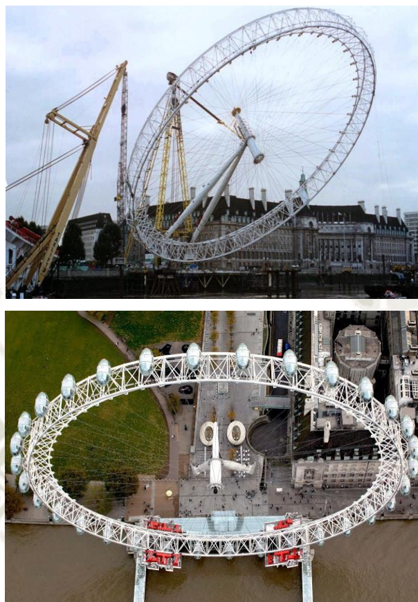
Fig. 3 - Fig. 4 Proceso de montaje del London Eye & Vista lateral del London Eye
