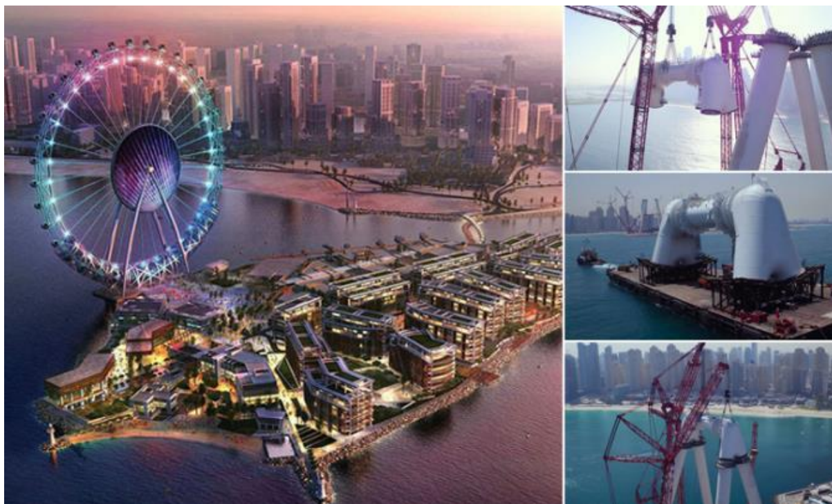
Fig. 14 Vista General del Ain Dubai, y detalles de montaje del spindle & hub central.
