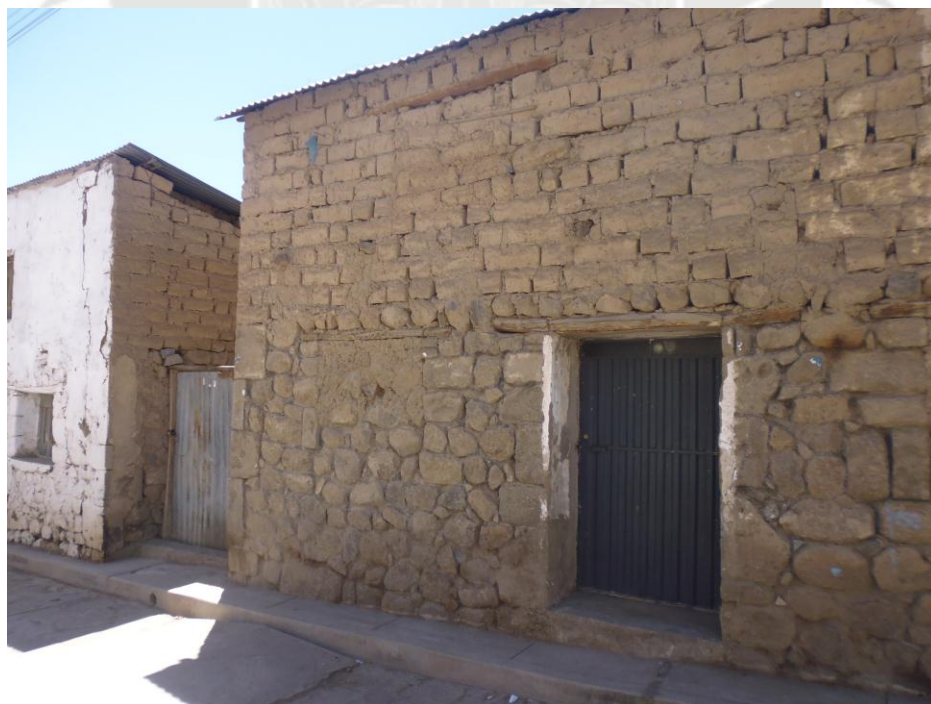
Figura 4.28 Vivienda de adobe y pircado
