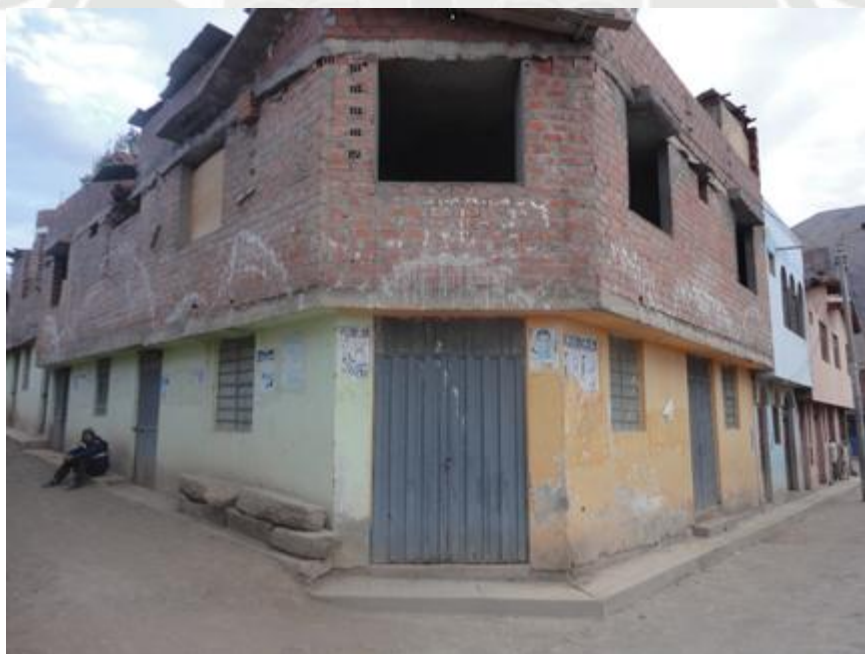
Figura 4.10 Vivienda de albañilería de 2 pisos
