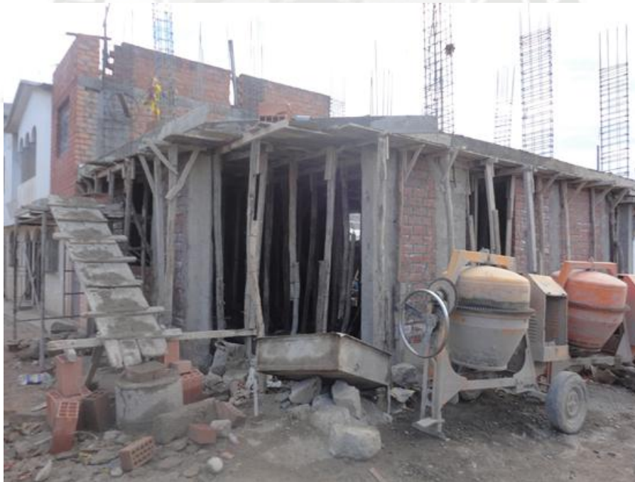
Figura 4.14 Vivienda en construcción
