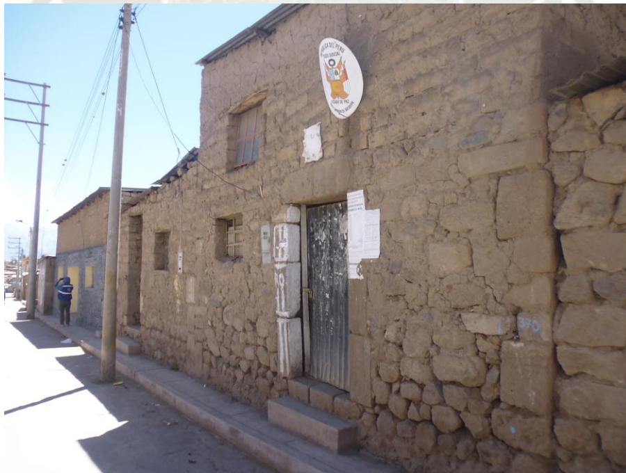
Figura 4.26 Vivienda de adobe y pircado
