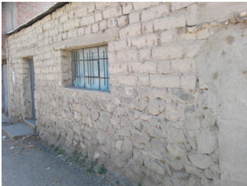
Figura 4.27 Vivienda de adobe y pircado
