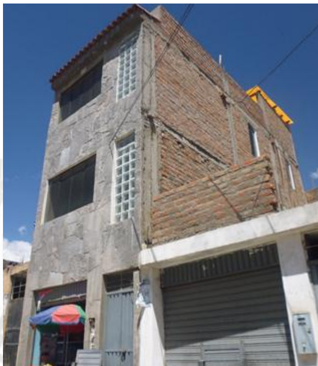
Figura 4.9 Vivienda de albañilería de 3 pisos
