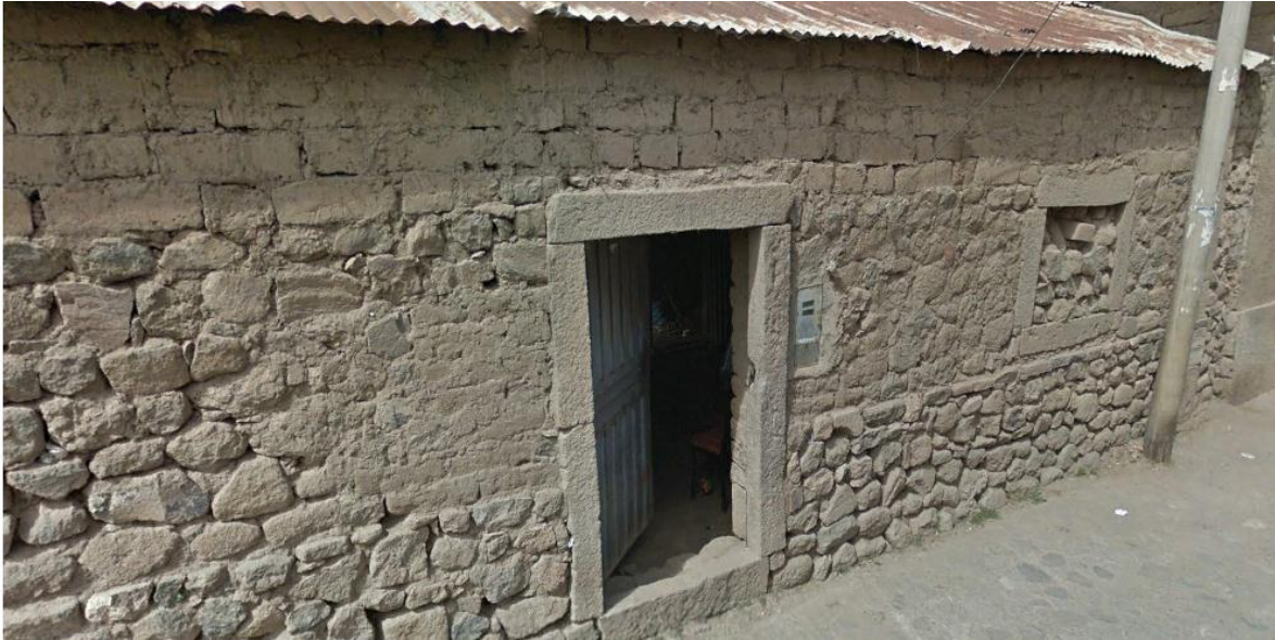
Figura 4.29 Vivienda de adobe y pircado
