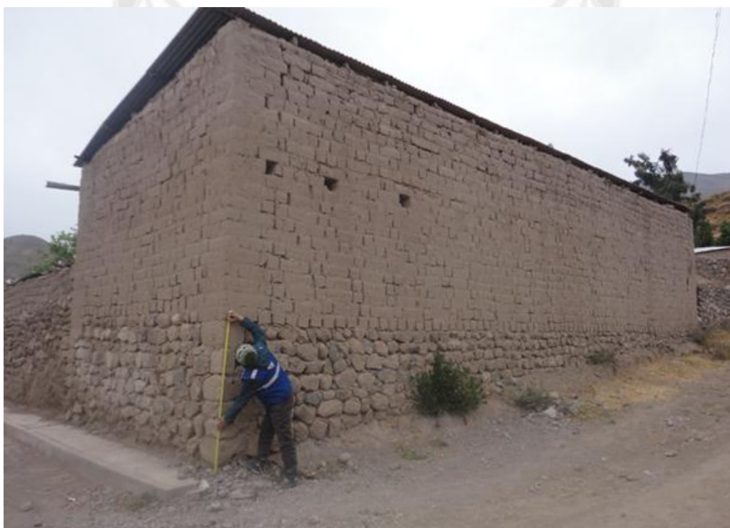
Figura 4.3 Vivienda de adobe y pircado.
