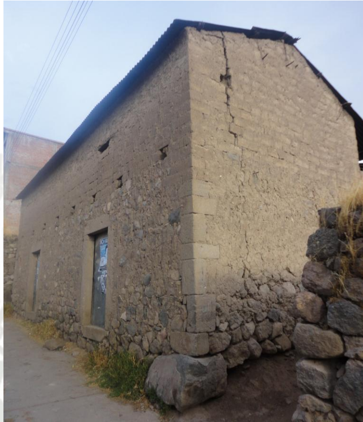
Figura 4.24 Vivienda de adobe y pircado
