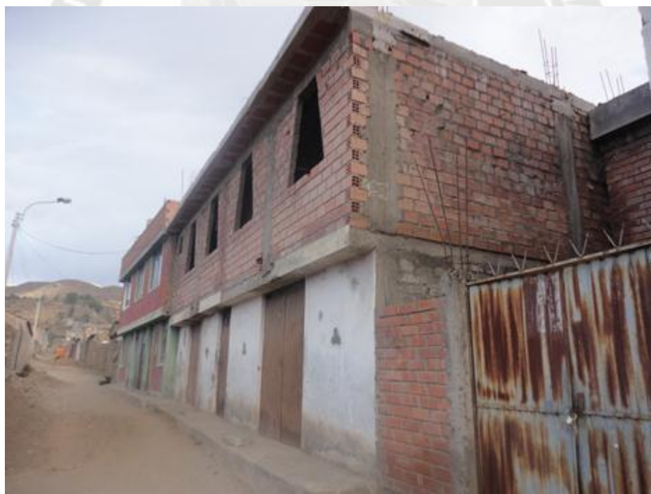
Figura 4.8 Vivienda de albañilería de 2 pisos
