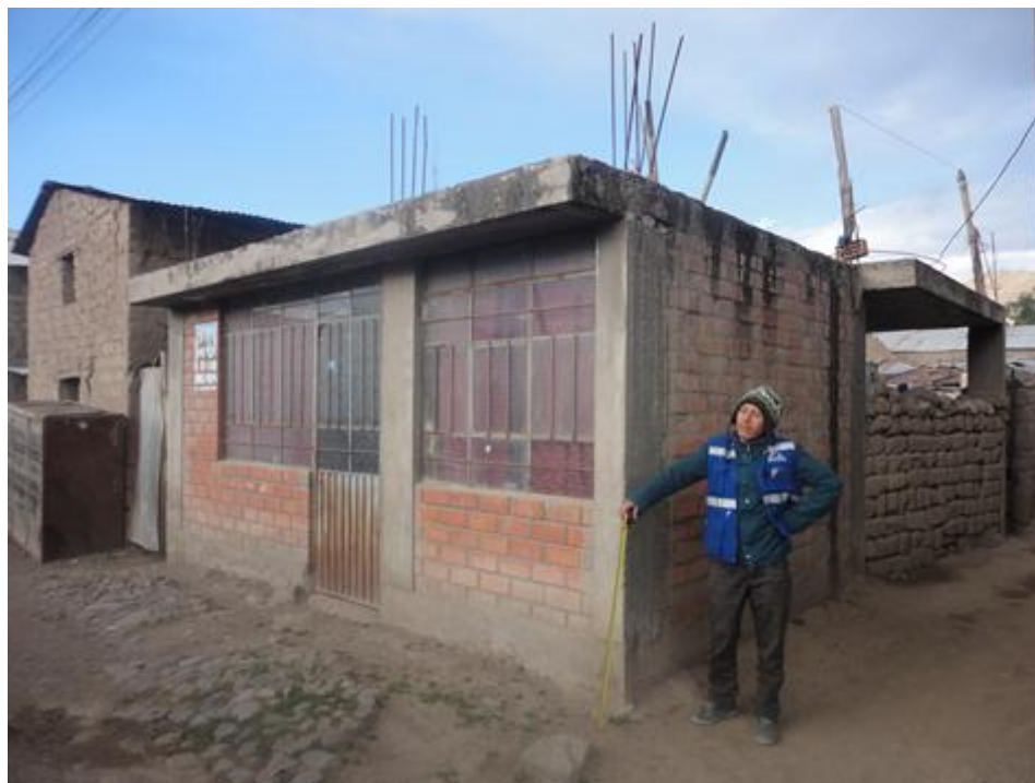
Figura 4.7 Vivienda de albañilería de 1 piso
