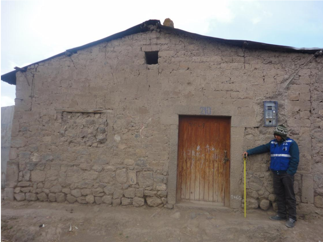
Figura 4.25 Vivienda de adobe y pircado
