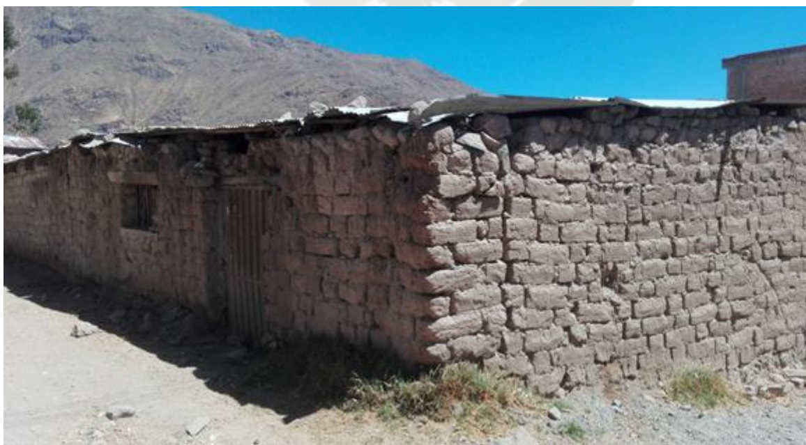
Figura 4.18 Vivienda de adobe
