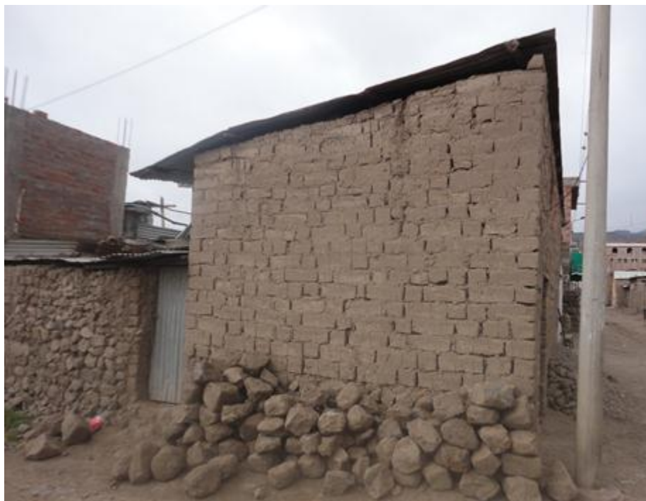
Figura 4.19 Vivienda de adobe
