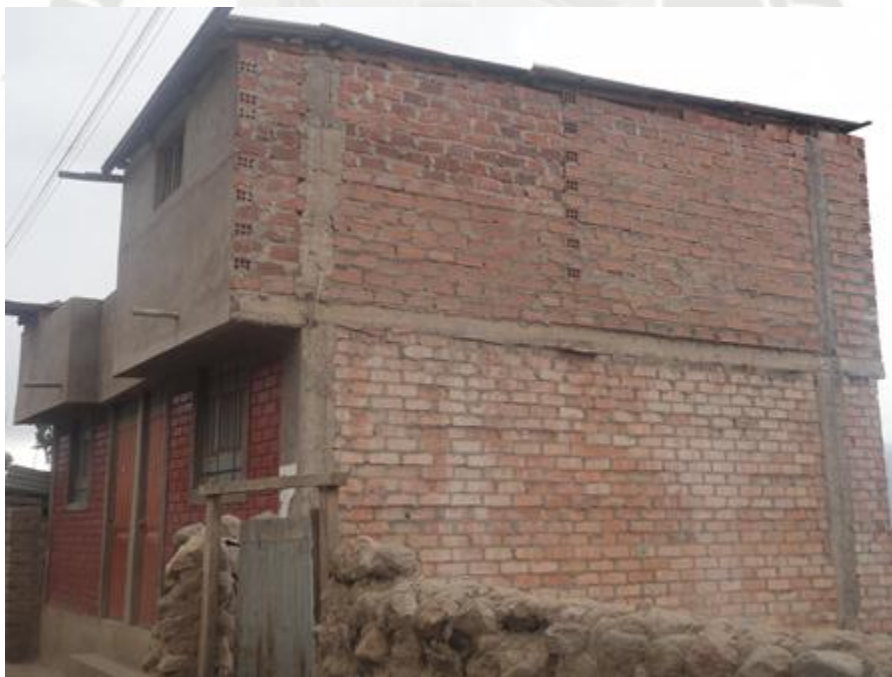
Figura 4.6 Vivienda de albañilería de 2 pisos
