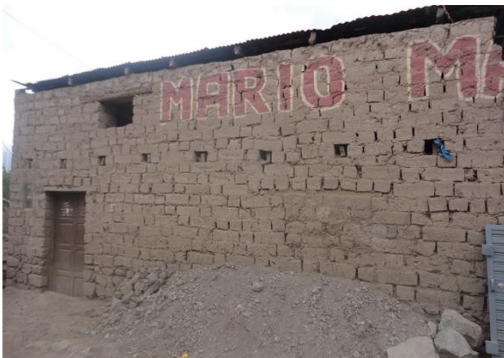
Figura 4.21 Vivienda de adobe
