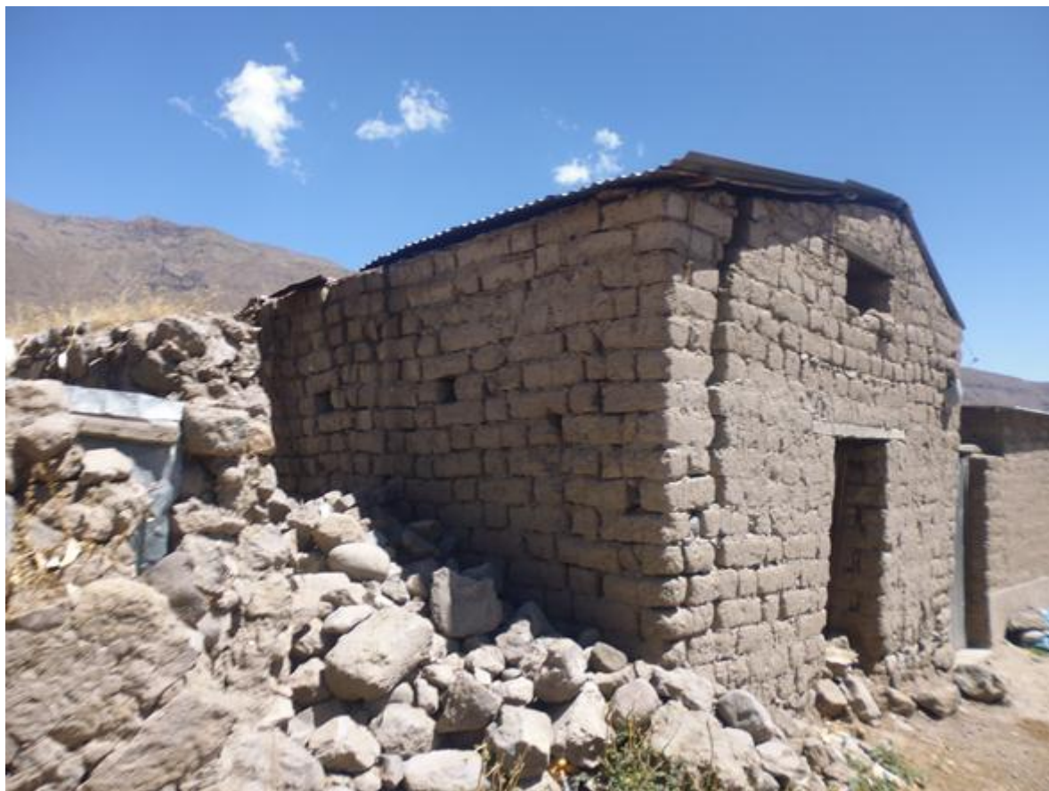
Figura 4.17 Vivienda de adobe
