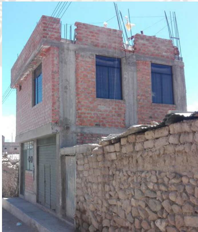
Figura 4.4 Vivienda de albañilería de 2 pisos
