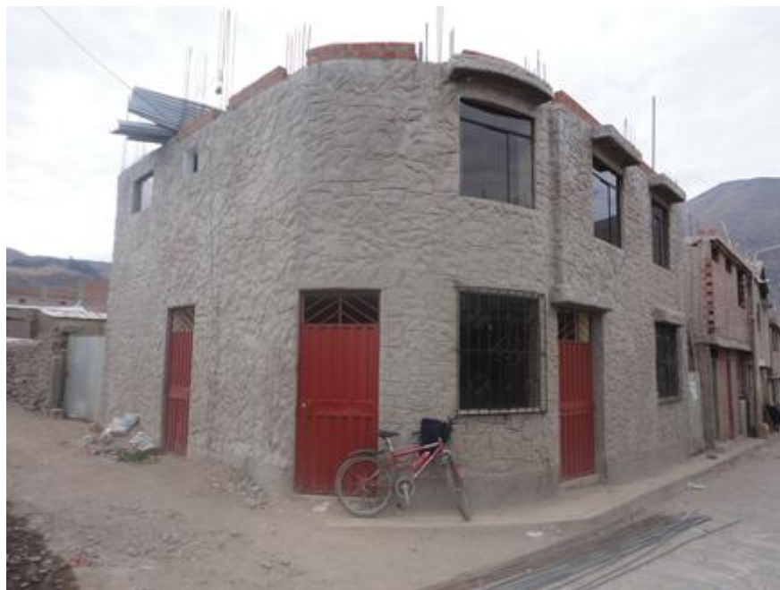
Figura 4.5 Vivienda de albañilería de 2 pisos revestida
