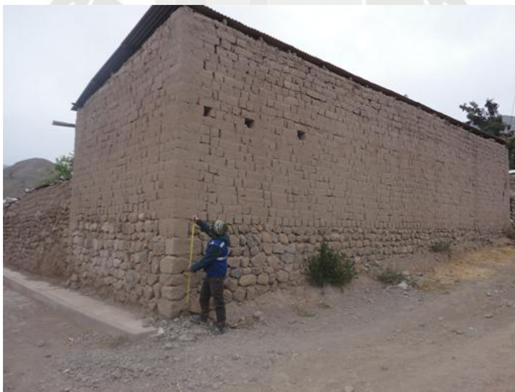
Figura 4.20 Vivienda de adobe
