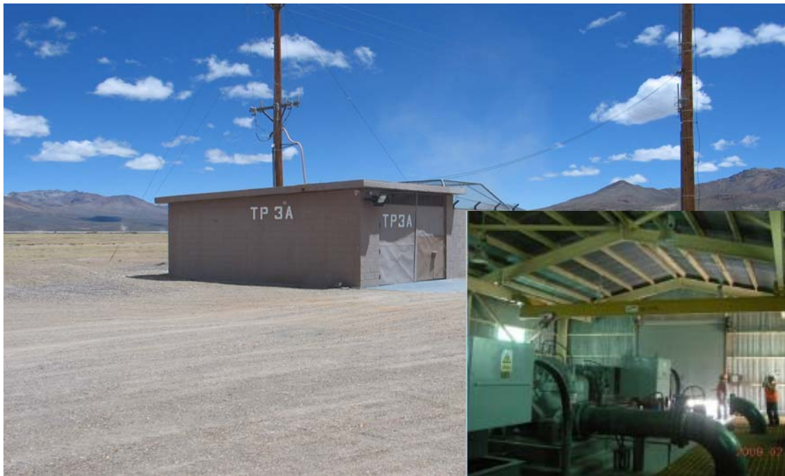
Figura 56. Caseta de pozo para la extracción de agua subterránea (SPCC)
