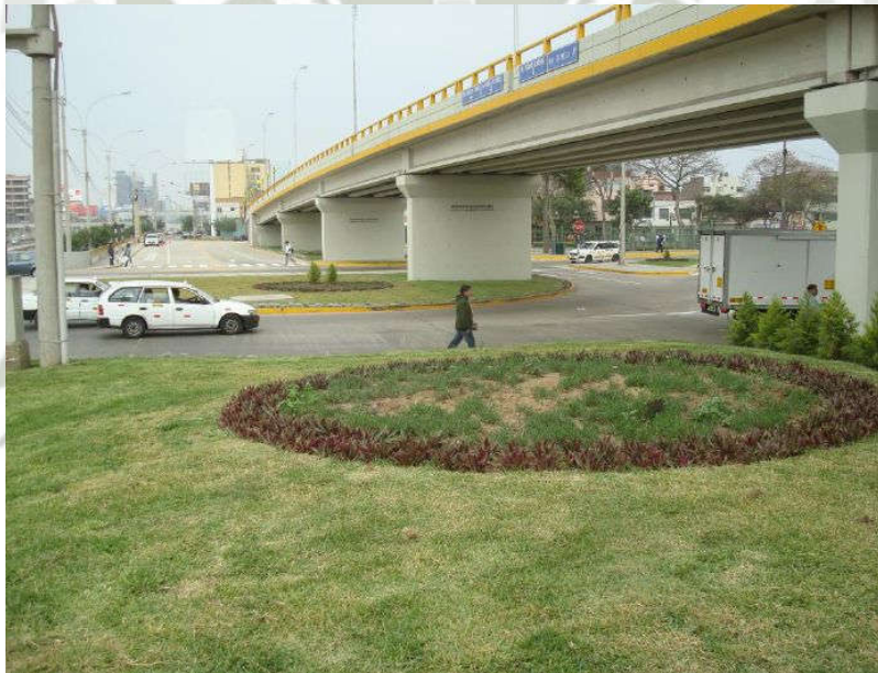
Figura 1 6 .- Puente Tipo Viga Losa
