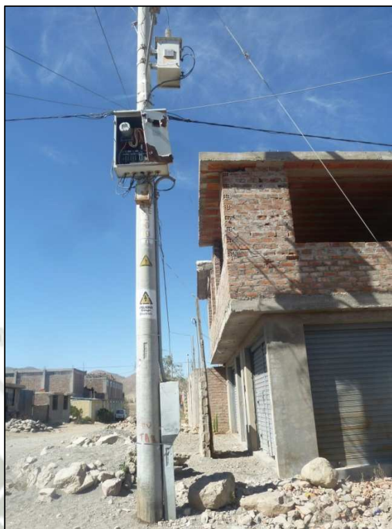
Foto N°17: Deficiencia 3052. Sin Rejilla o con Rejillas de Ventilación y de Ingreso Rotas, Hundidas o Sin Cierre Seguro.
