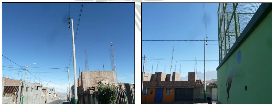
Figura 44: EMT sin retenida y armados diferentes
