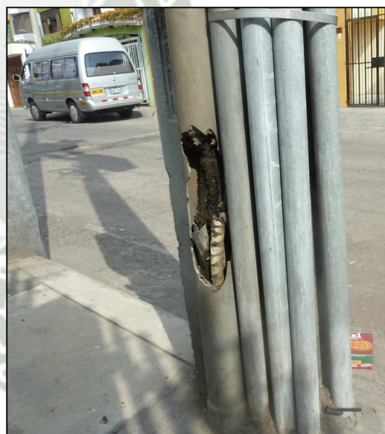
Foto N°05: Deficiencia 1036. Partes Rígidas Bajo Tensión No Protegidas, Incumplen Distancia de Seguridad Respecto a Líneas de Comunicación.
