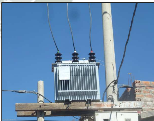
Foto N°11: Deficiencia 2024. Partes Rígidas Bajo Tensión No Protegidas, Incumplen Distancia de Seguridad Respecto a Edificación.
