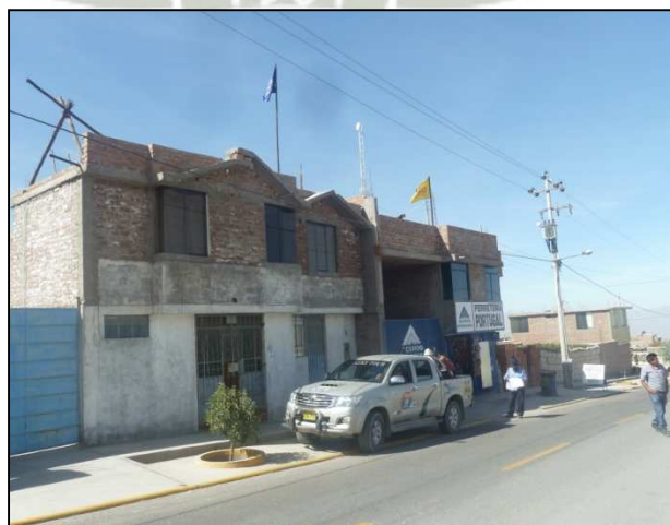
Foto N°20: Deficiencia 5026. Conductor Incumple Distancia de Seguridad Respecto a Edificación.
