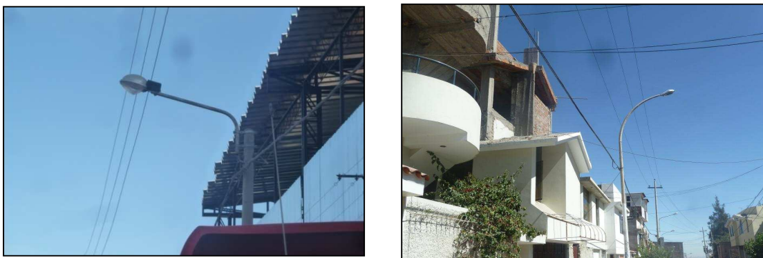
Figura 39: DMS a pastorales de iluminación con respecto a redes de MT
