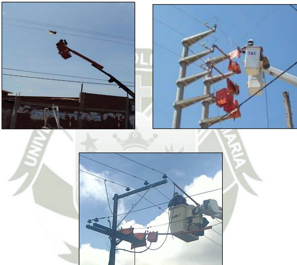
Figura 53: Mantenimiento en Caliente - ENOSA, Tumbes.
