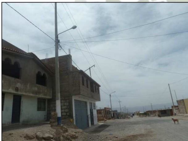
Foto N°22: Deficiencia 5038. Conductor Esta Sobre Edificación.
