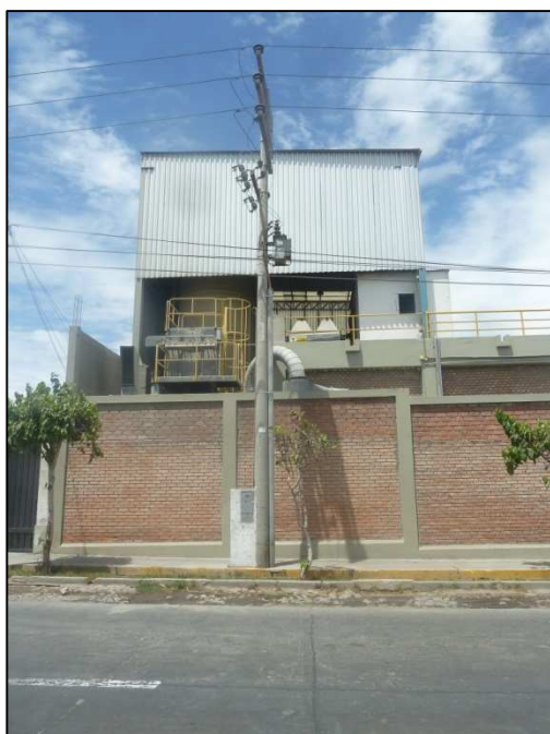
Foto N°05: Deficiencia 1036. Partes Rígidas Bajo Tensión No Protegidas, Incumplen Distancia de Seguridad Respecto a Líneas de Comunicación.
