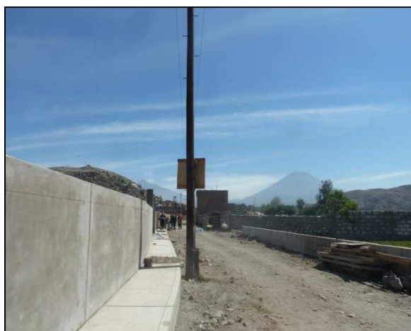
Foto N°03: Deficiencia 1012. Expuesta al Impacto Vehicular.
