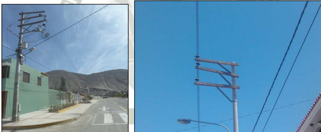
Figura 38: Crucetas giradas acercamiento entre fases.
