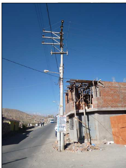
Figura 26: Incumplimiento de las distancias mínimas de seguridad
