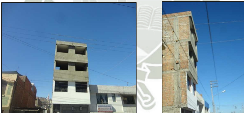
Figura 30: Deficiencia de Origen Externo, Edificación recientemente construida invadiendo aires de vía pública – AMT JESÚS
