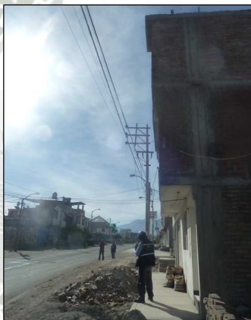
Foto N°19: Deficiencia 5018. Conductor Incumple Distancia de Seguridad Respecto a Estructura y/o Cable de Comunicación.
