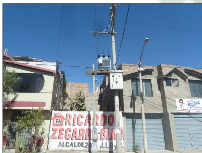
Foto N°11: Deficiencia 2024. Partes Rígidas Bajo Tensión No Protegidas, Incumplen Distancia de Seguridad Respecto a Edificación.
