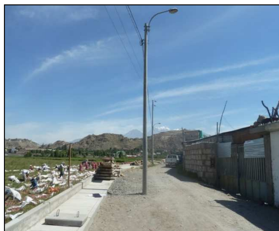
Foto N°03: Deficiencia 1012. Expuesta al Impacto Vehicular.
