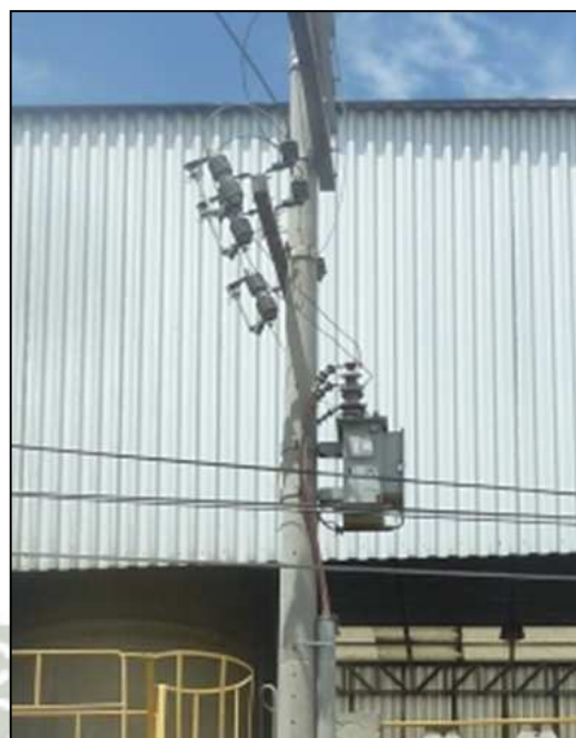
Foto N°05: Deficiencia 1036. Partes Rígidas Bajo Tensión No Protegidas, Incumplen Distancia de Seguridad Respecto a Líneas de Comunicación.
