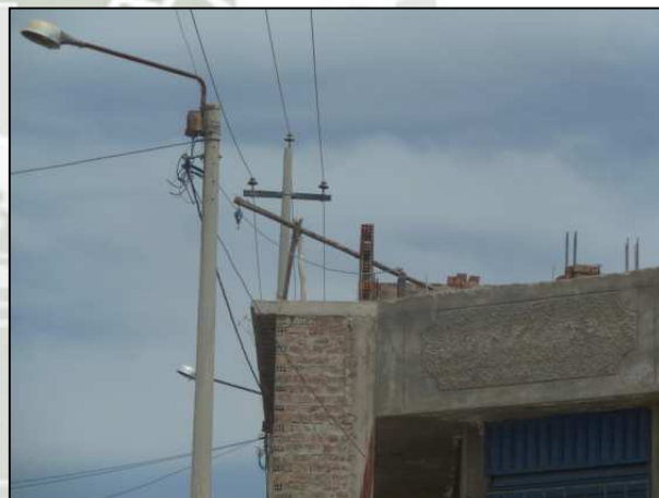
Foto N°22: Deficiencia 5038. Conductor Esta Sobre Edificación.
