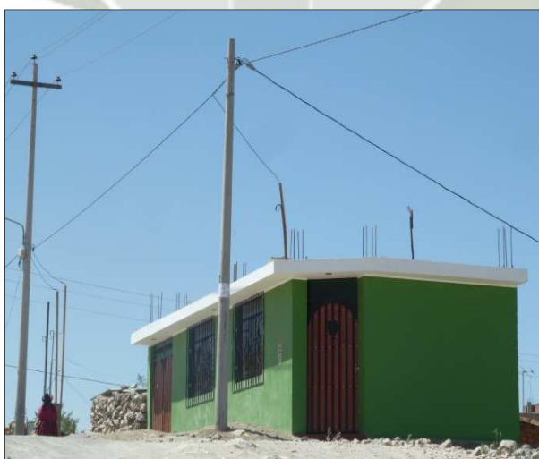
Figura 33: Deficiencia de Origen Interno, Instalación de EBT en vía no definidas
