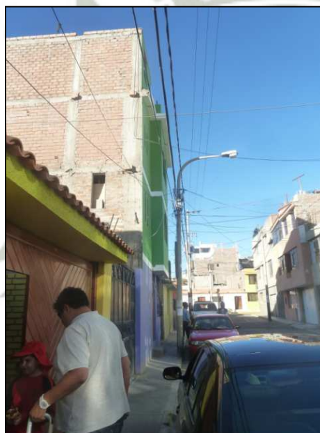
Foto N°19: Deficiencia 5018. Conductor Incumple Distancia de Seguridad Respecto a Estructura y/o Cable de Comunicación.
