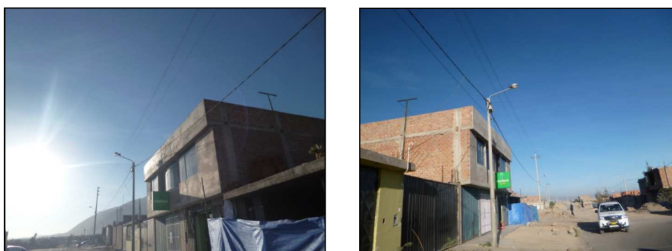
Figura 55: Incumplimiento en el levantamiento de deficiencias
