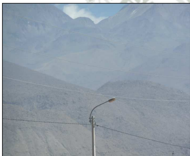
Foto N°21: Deficiencia 5032. Conductor Incumple Distancia de Seguridad Respecto a Instalación de Baja Tensión.
