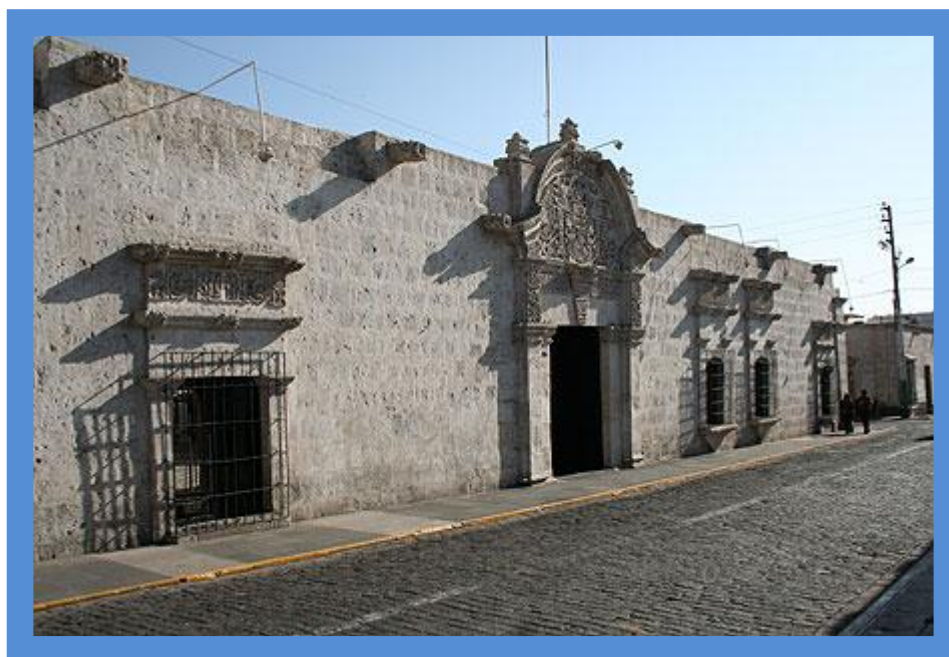
Imagen N°21: Fachada Casa del Moral
