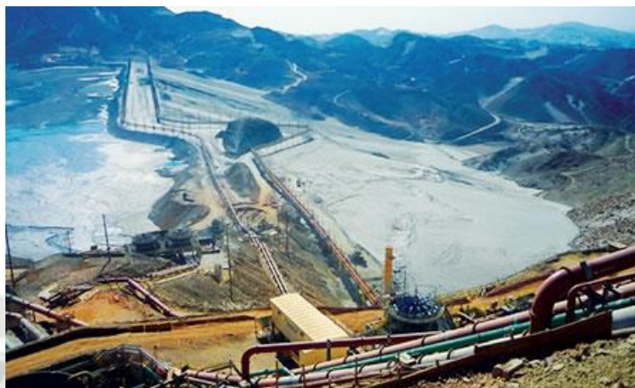
Figura 2.5: Represa de relaves (SMCV – Arequipa).
