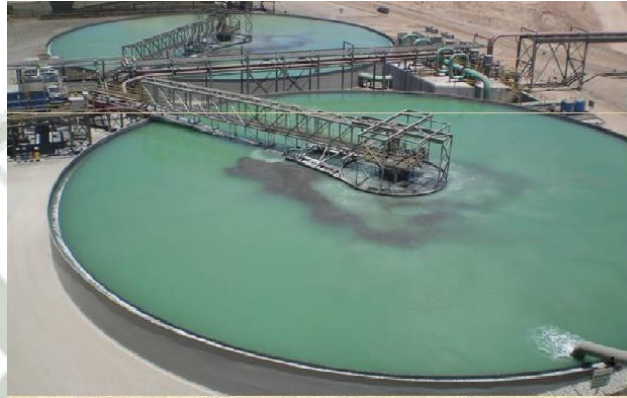
Figura 2.4: Espesadores de relaves (SMCV – Arequipa)
