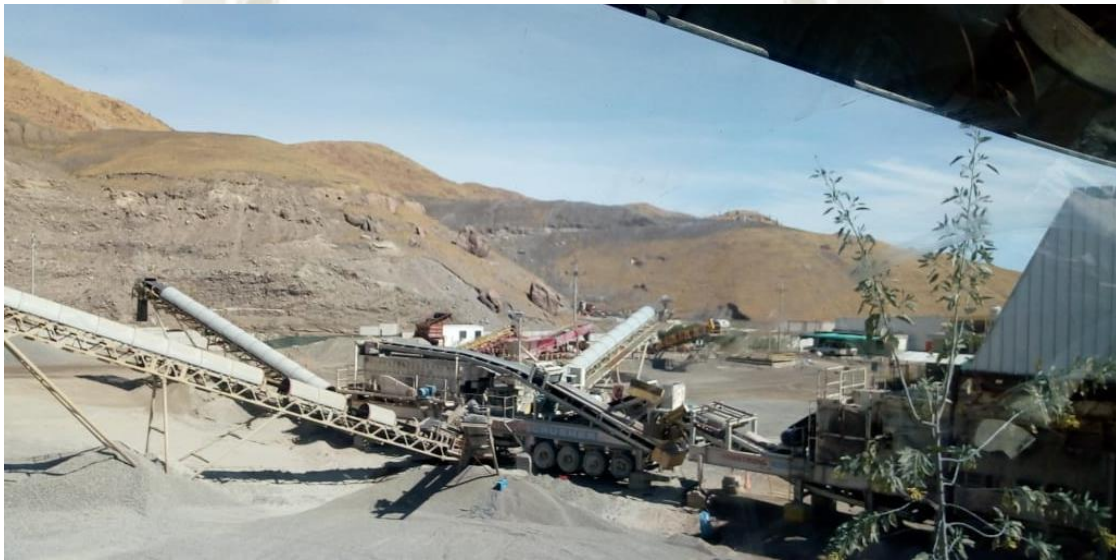
Figura 28 Repuestos en parada sin orden
