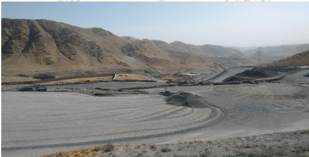
Figura 24 Almacén de despachos agregados
