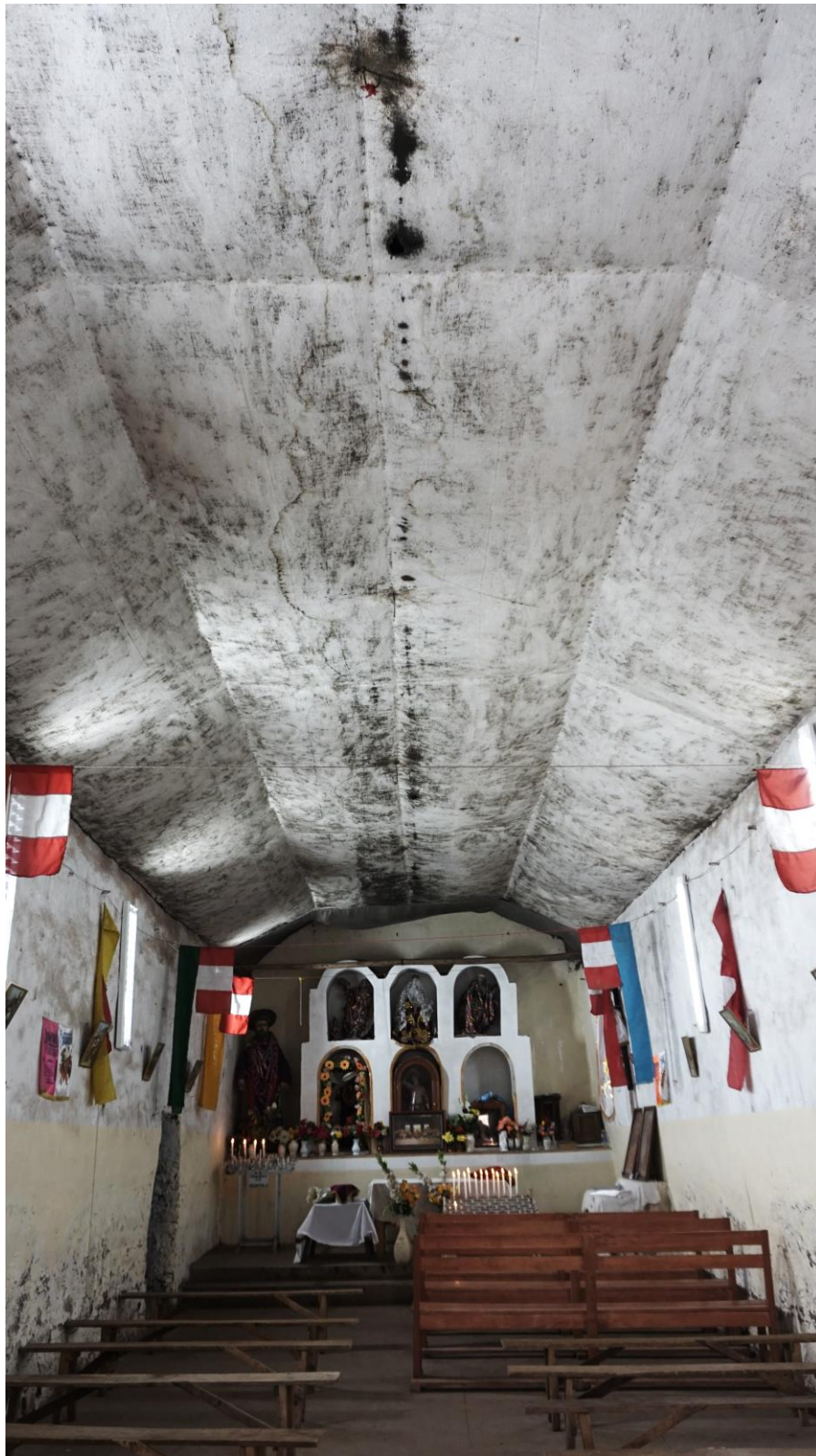
Figura 10. Capilla de Escallani, interior Fuente: Elaboración propia
