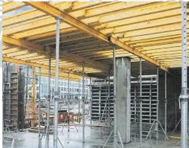
Figura N° X.2.- Proceso Constructivo de la Superestructura de la Edificación
