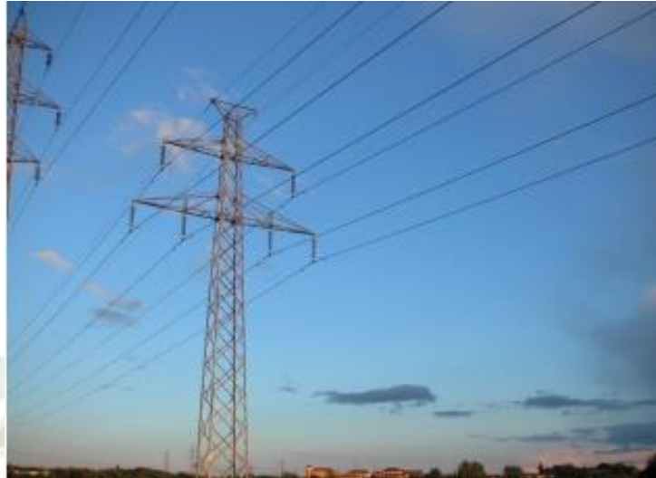
Figura N°6. Torre de Transmisión
