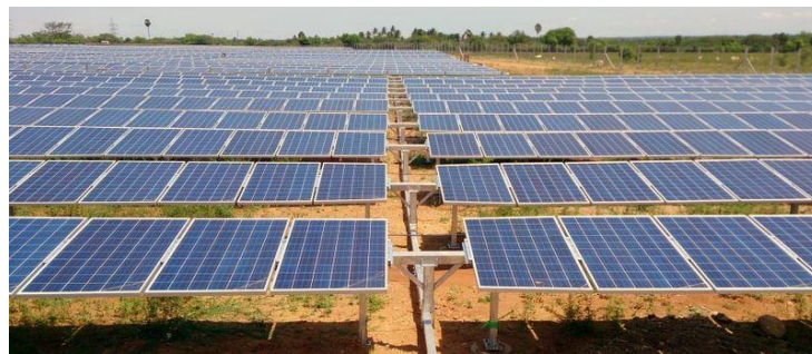
Figura 2-18: Seguidor en una planta de 4MW en Vellakoil. (Tamil Nadu, India)
