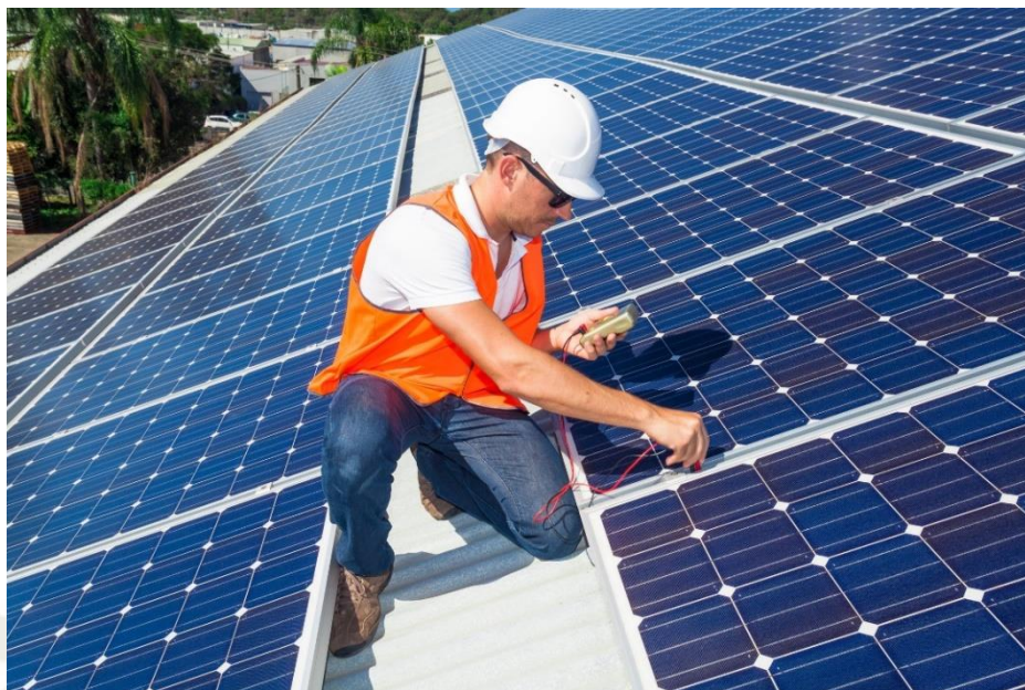
Figura 4-2: Revisión de parámetros eléctricos de paneles FV.
