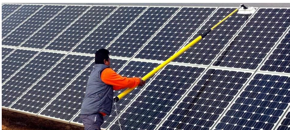
Figura 4-1: Limpieza de la superficie exterior de paneles FV.
