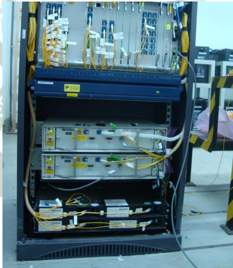
FIGURA 6-26 INSTALACIÓN DE FIBRA OPTICA (MÓDULO CRPC)
